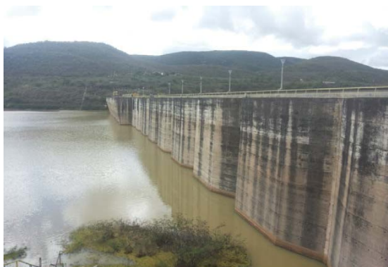
Foto 01: Vista de montante para barragem.
