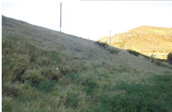
Foto 01: Paramento de jusante.
