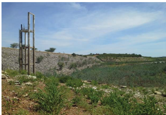
Foto 01: Vista de montante para a barragem.
