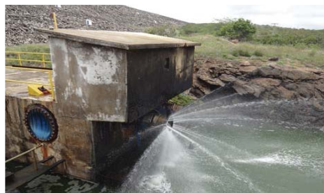
Foto 02: Liberação para jusante válvula dispersora.
