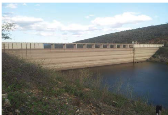
Foto 01: Vista de montante para barragem.
