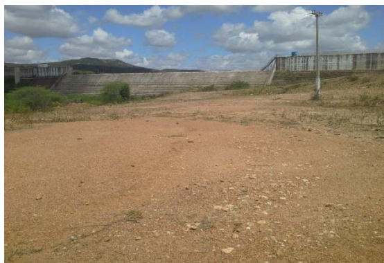
Foto 01: Vista de jusante para barragem.
