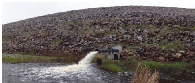
Foto 01: Vista de jusante para a barragem liberação para jusante.
