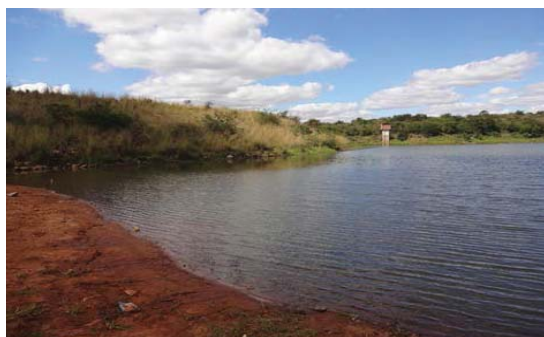
Foto 01: Vista de montante para a barragem.
