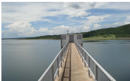
Foto 02: Torre de comando da tomada d'água. (Fonte: Google Earth)
