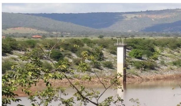
Foto 01: Vista de montante para a barragem.
