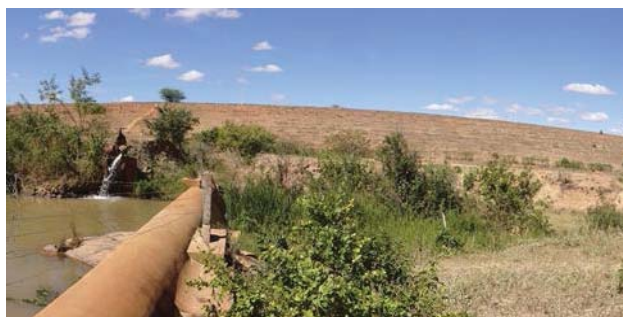
Foto 01: Vista de jusante para a barragem.
