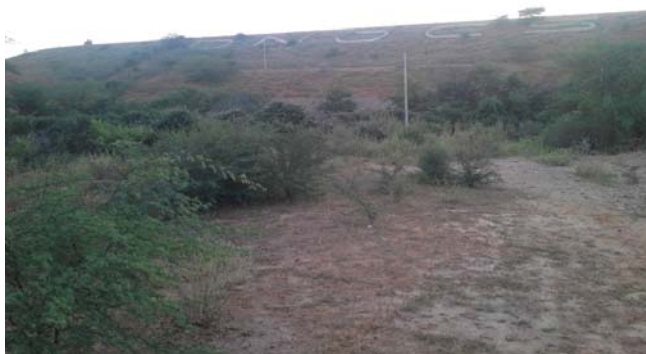
Foto 01: Vista de jusante para a barragem.
