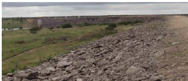
Foto 01: Paramento de montante da barragem.
