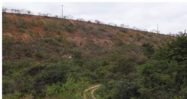
Foto 01: Vista de jusante para a barragem.
