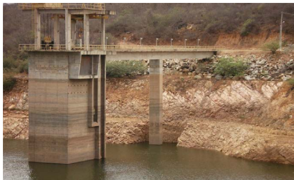
Foto 02: Torre de comando da tomada d'água Fonte: Google Earth
