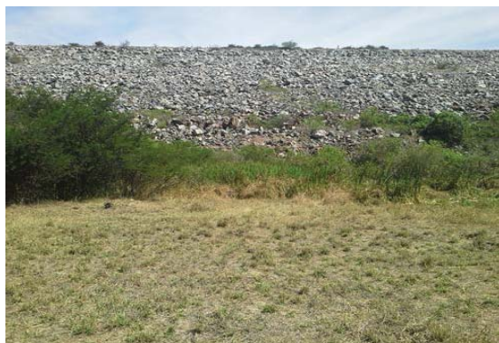
Foto 01: Detalhe do paramento de jusante.
