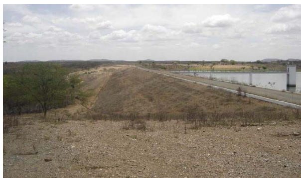
Foto 01: Paramento de montante. (Fonte: Google Earth)
