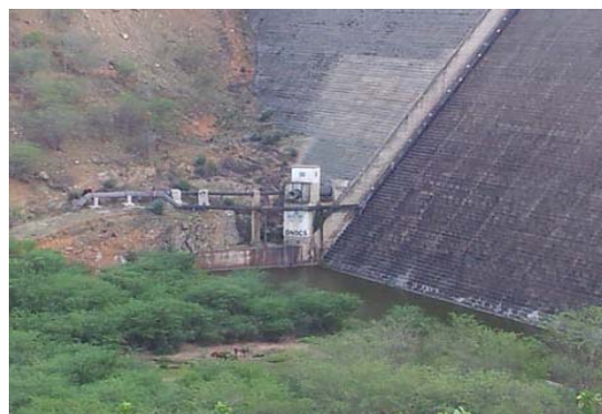
Foto 02: Tomada d'água a jusante - válvula dispersora.
