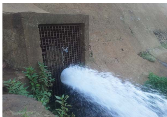
Foto 02: Tomada d'água - liberação para jusante.
