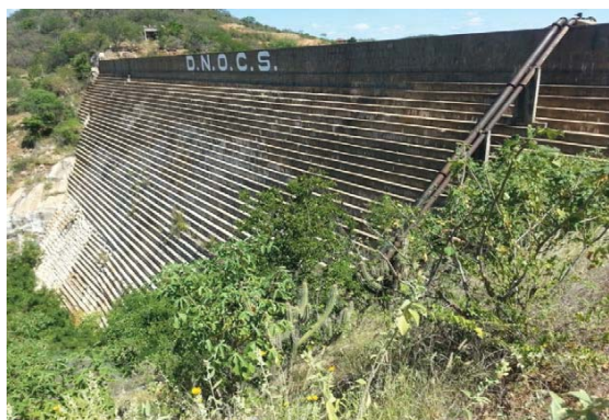
Foto 01: Detalhe do paramento de jusante.
