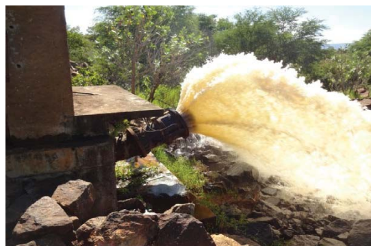
Foto 02: Liberação para jusante - válvula dispersora.
