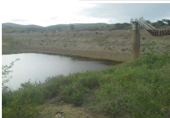
Foto 01: Vista de montante para barragem.
