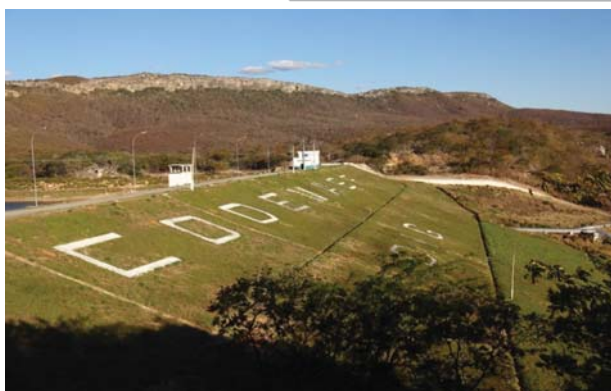
Foto 01: Paramento de montante da barragem.
