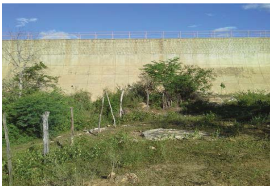
Foto 01: Vista de jusante para barragem.
