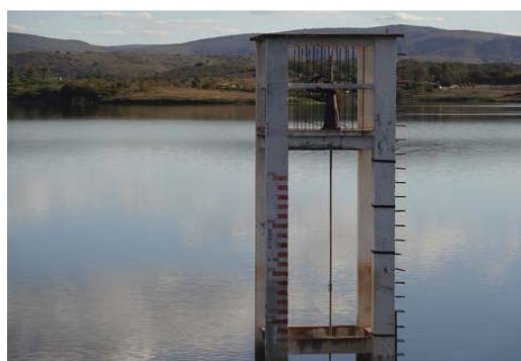
Foto 02: Torre de comando da comporta e régua linimétrica.
