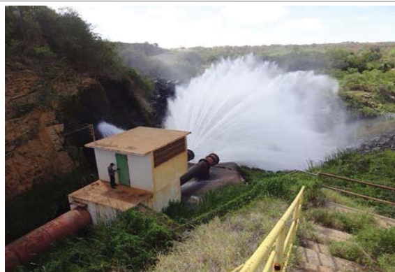
Foto 02: Liberação para jusante - válvula dispersora.
