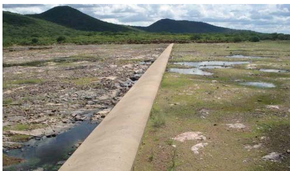
Foto 01: Vertedouro da barragem. (Fonte: Google Earth)
