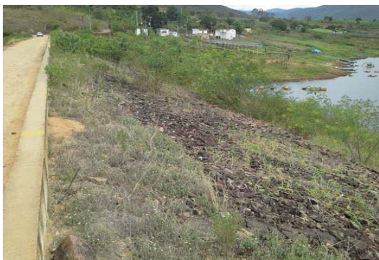
Foto 01: Detalhe do paramento de montante.
