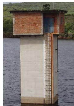
Foto 02: Torre de controle da tomada d'água, com régua linimétrica.
