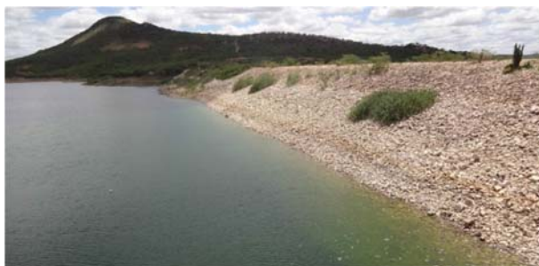
Foto 01: Detalhe do paramento de montante.
