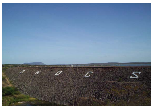
Foto 01: Vista de jusante para barragem. (Fonte: Google Earth)
