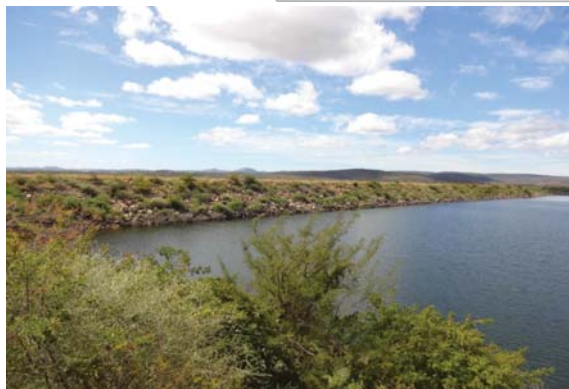
Foto 01: Paramento de montante.
