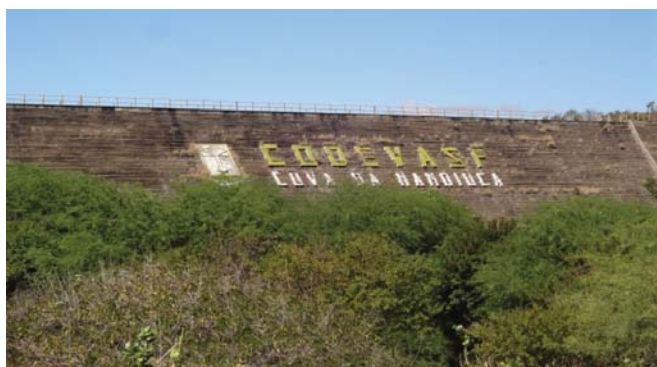
Foto 01: Detalhe do paramento de jusante.
