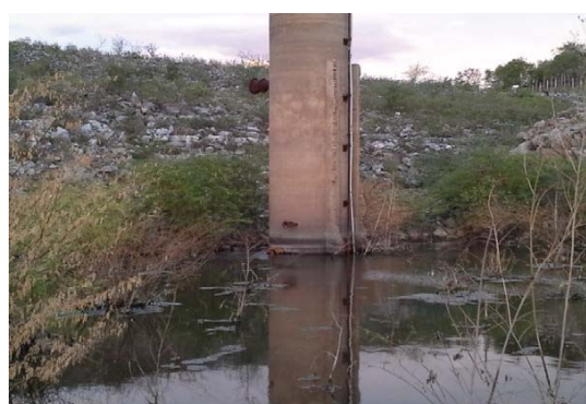
Foto 02: Torre de comando da tomada d'água.
