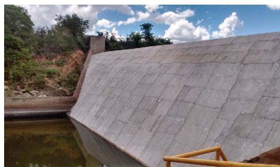
Foto 02: Vertedouro da barragem. (Fonte: http://emersonviuassim.blogspot.com.br/ )
