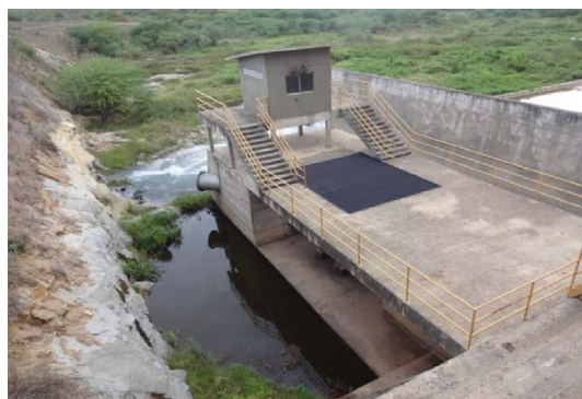
Foto 02: Casa de comando da válvula dispersora.
