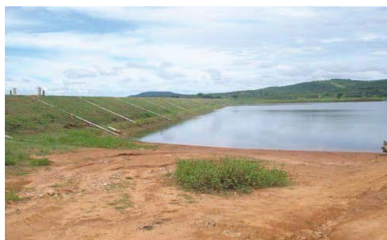
Foto 02: Vista de montante para a barragem. (Fonte: Google Earth)
