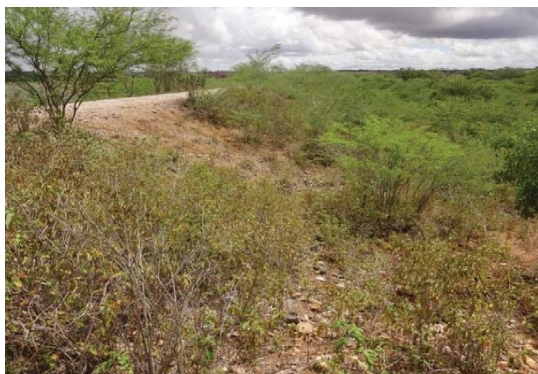
Foto 01: Paramento de jusante.
