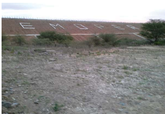
Foto 01: Vista de jusante para a barragem.
