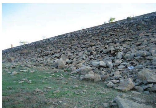
Foto 01: Detalhe do paramento de jusante. (Fonte: Google Earth)
