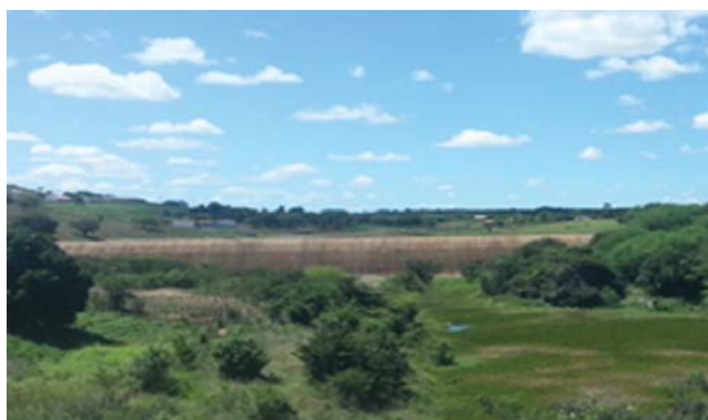
Foto 01: Vista de jusante para a barragem.
