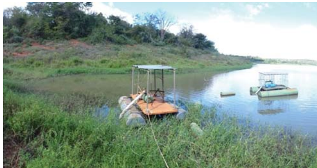
Foto 02: Captações sobre flutuantes - abastecimento humano.
