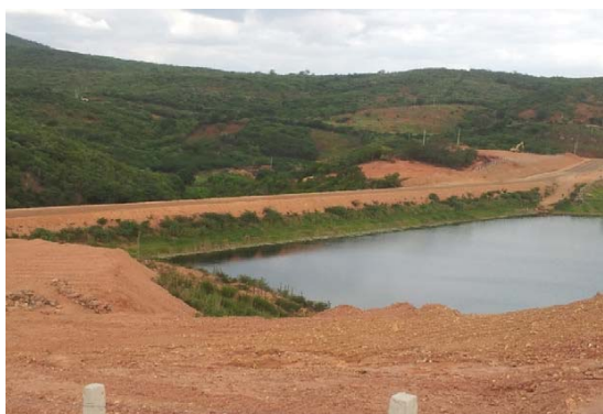
Foto 01: Vista de montante para barragem.
