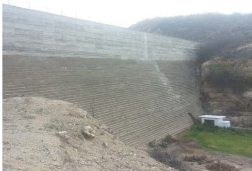
Foto 01: Vista de jusante da barragem e casa de controle da tomada d'água.
