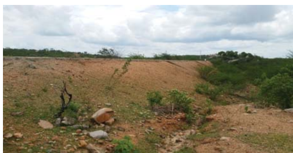
Foto 01: Detalhe do paramento de jusante da barragem.
