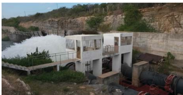
Foto 02: Comando das válvulas dispersoras.
