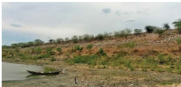
Foto 01: Detalhe de paramento de montante da barragem.
