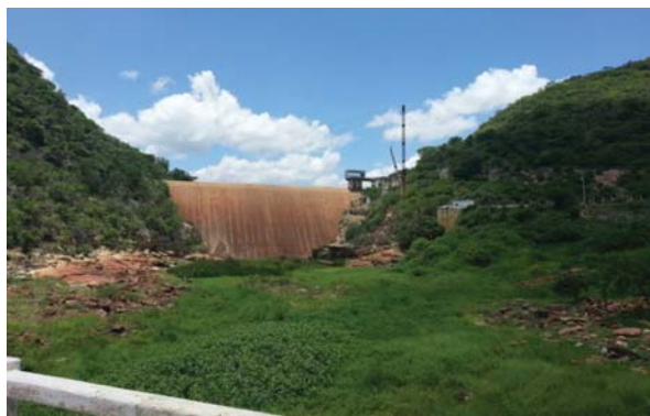
Foto 01: Barragem vertedoura, corte efetuado em rochas.
