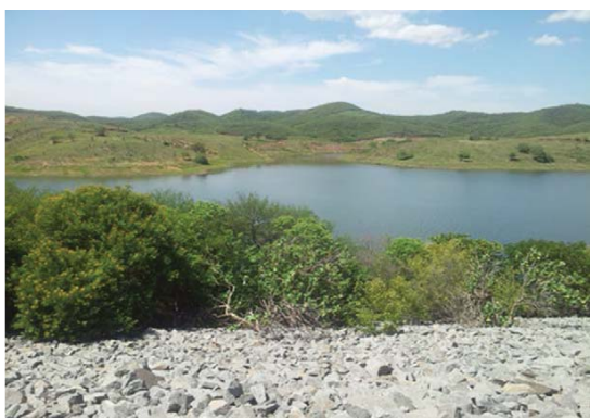
Foto 01: Vista da barragem para montante.
