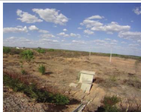
Foto 02: Saída da tomada d'água.
