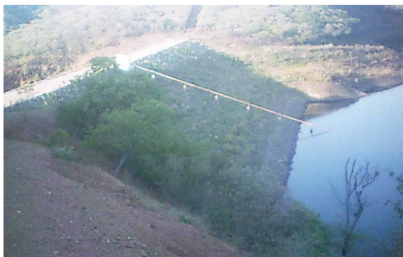
Foto 01: Paramento de montante com vegetação.
