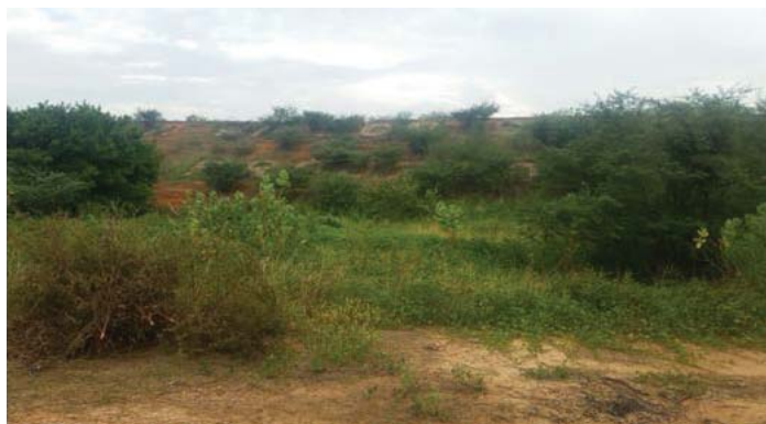
Foto 01: Paramento de jusante.
