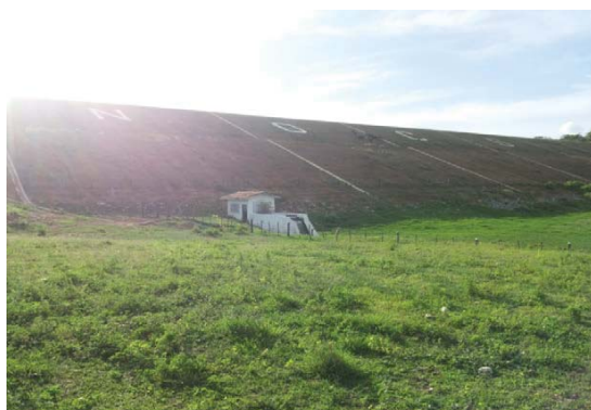
Foto 01: Paramento de jusante e caixa de dissipação.
