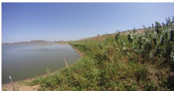
Foto 01: Vista de montante para barragem.
