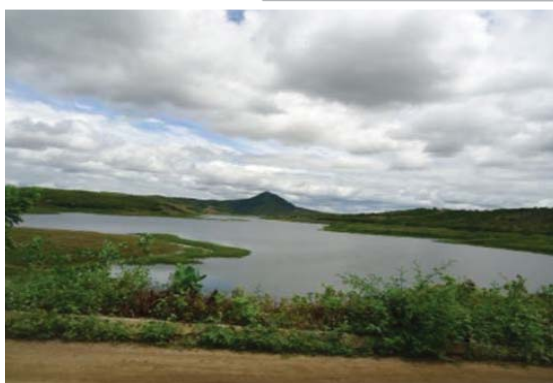
Foto 01: Vista da barragem para montante.
