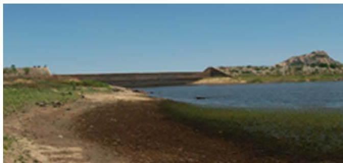
Foto 01: Vista de montante para a barragem.
