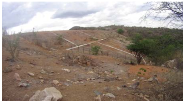
Foto 01: Vista de jusante para barragem principal.
