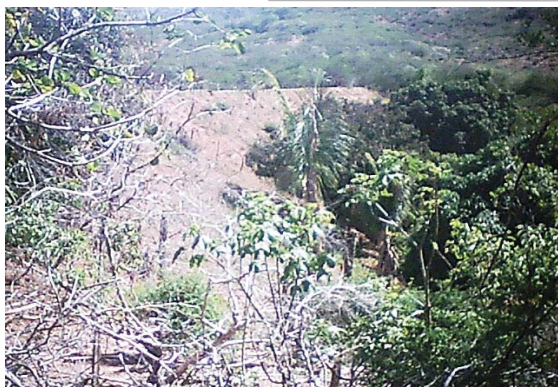
Foto 01: Vista do paramento de jusante da barragem.
