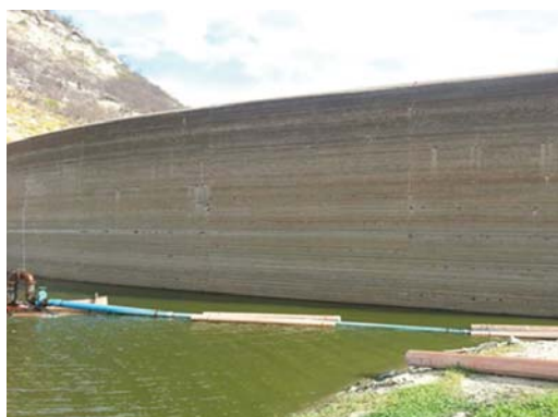
Foto 01: Detalhe do paramento de montante.
