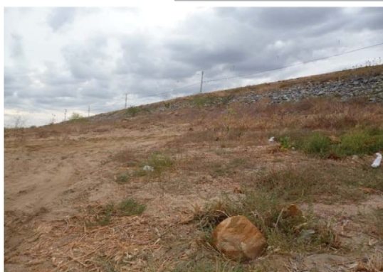
Foto 01: Detalhe do paramento de jusante.
