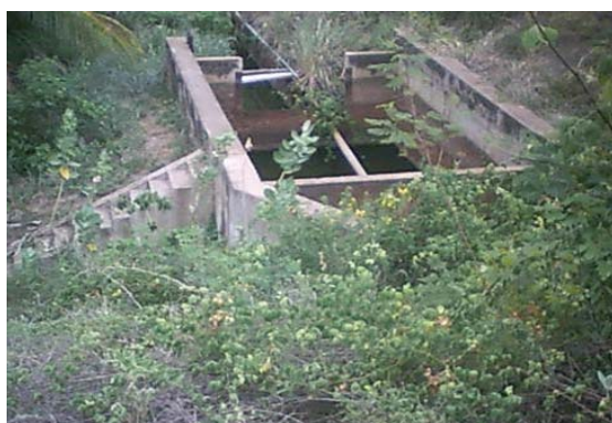
Foto 02: Tomada d'água principal - liberação para jusante.
