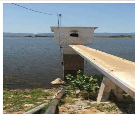
Foto 02: Torre de controle da tomada d'água.
