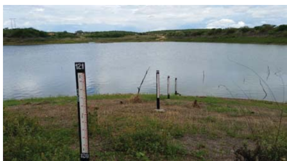
Foto 02: Conjunto de réguas do reservatório.
