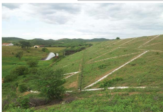
Foto 01: Detalhe do paramento de jusante.
