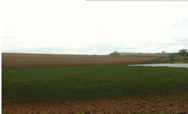
Foto 01: Vista de montante para barragem.
