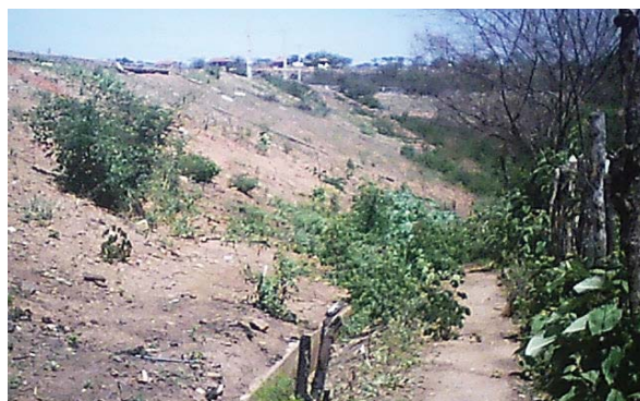
Foto 01: Paramento de jusante da barragem.
