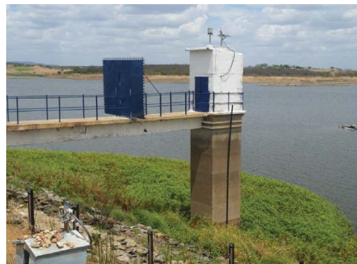
Foto 02: Torre de comando da comporta, PCD e linígrafo.
