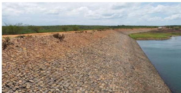
Foto 01: Detalhe do paramento de montante da barragem.
