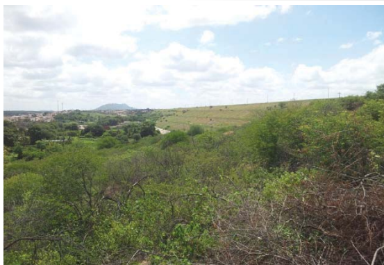
Foto 01: Vista de jusante para barragem principal.
