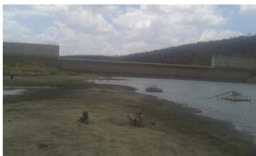
Foto 01: Vista de montante para barragem.
