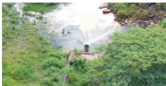
Foto 02: Liberação para jusante - válvula dispersora.
