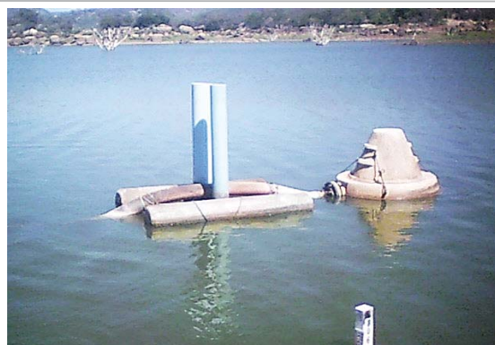
Foto 02: Tomada d'água da CAGEPA - bombas sobre flutuantes.
