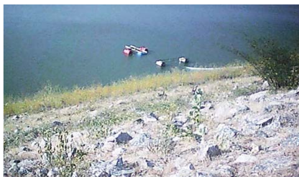
Foto 02: Captação flutuante provisória da CAGEPA.
