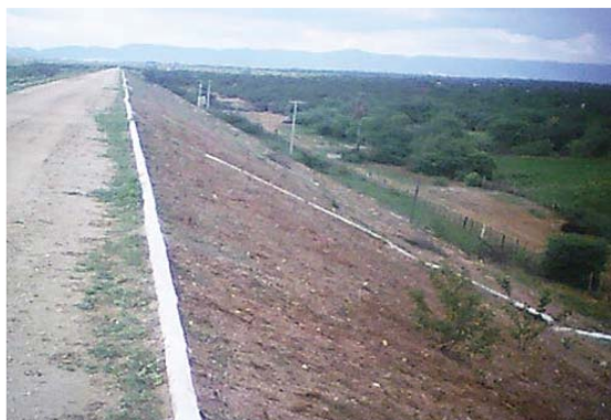
Foto 01: Paramento de jusante.
