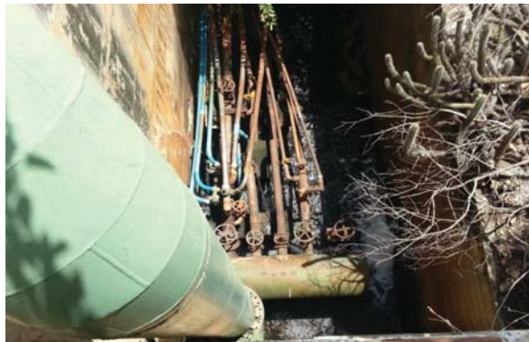
Foto 02: Tomada d'água para abastecimento de demandas.
