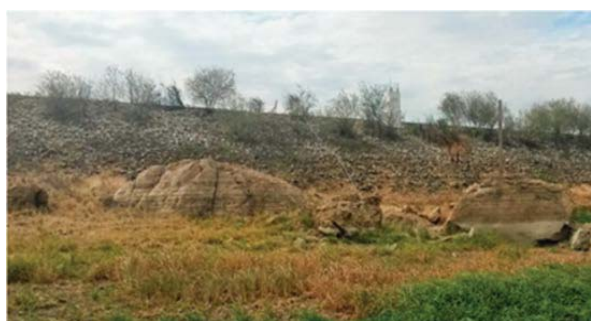
Foto 01: Vista de montante para a barragem.
