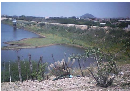
Foto 01: Vista de montante para a barragem.
