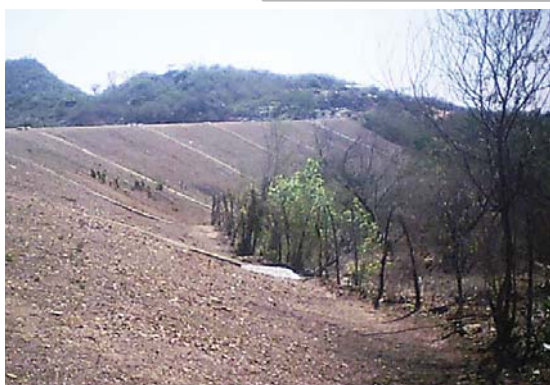
Foto 01: Detalhe do paramento de jusante.
