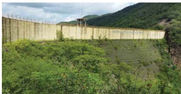
Foto 01: Vista de jusante para barragem.
