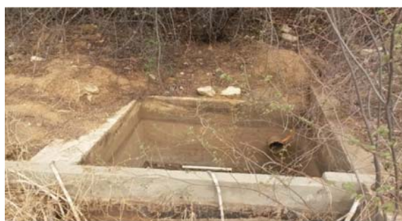
Foto 02: Detalhes da tomada d'água.
