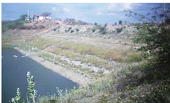
Foto 01: Paramento de montante principal.
