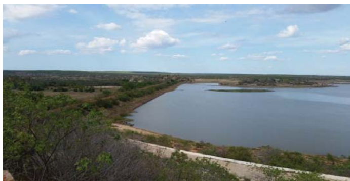
Foto 01: Vista de montante para a barragem.
