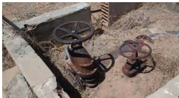
Foto 02: Tomada d'água - derivações com registros gaveta.
