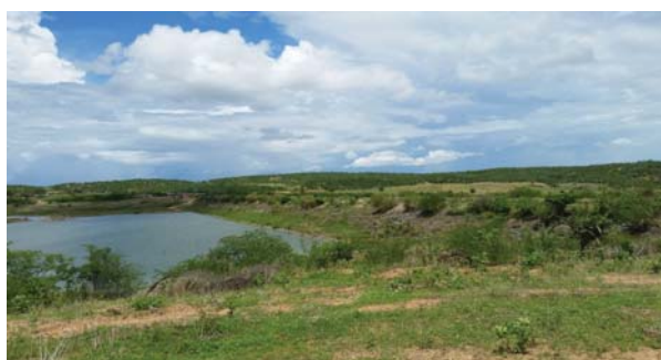
Foto 01: Vista de montante para a barragem.
