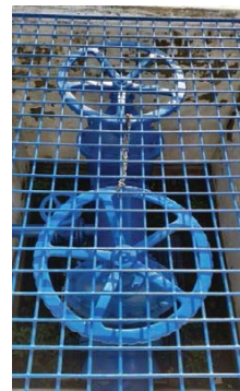
Foto 02: Liberação para jusante tubulação e registro de gaveta.
