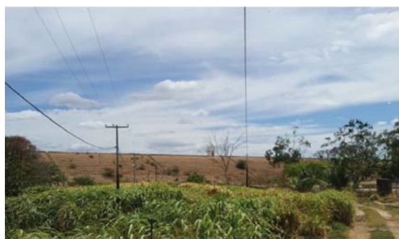
Foto 01: Vista de jusante para a barragem.
