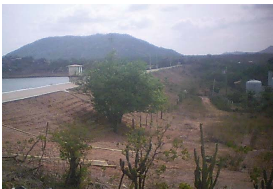
Foto 01: Vista para barragem principal.
