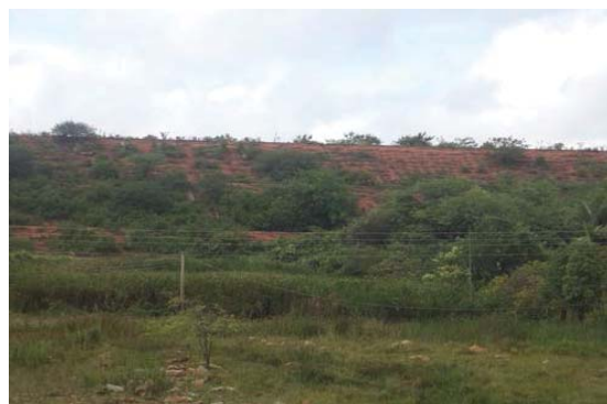
Foto 01: Vista de jusante para a barragem principal.
