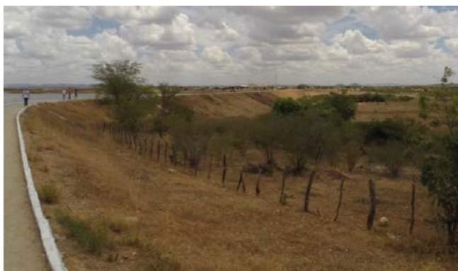
Foto 01: Vista de jusante para a barragem.
