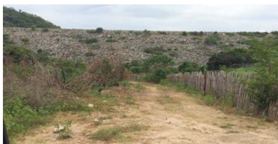
Foto 01: Vista de jusante para barragem.
