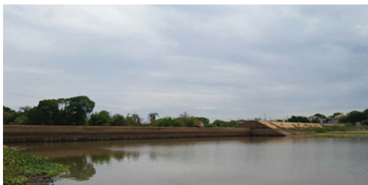
Foto 01: Vista de montante para a barragem.
