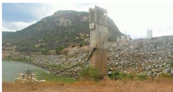
Foto 01: Paramento de montante e torre de comando.
