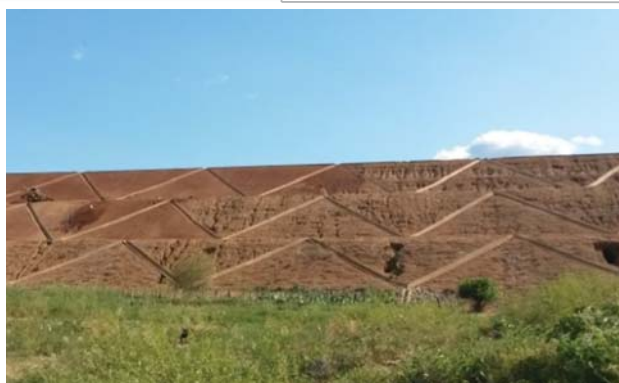
Foto 01: Vista de jusante para barragem.
