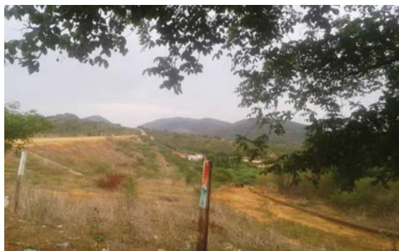
Foto 01: Vista de jusante para a barragem.
