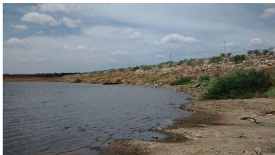
Foto 01: Vista de montante para barragem.
