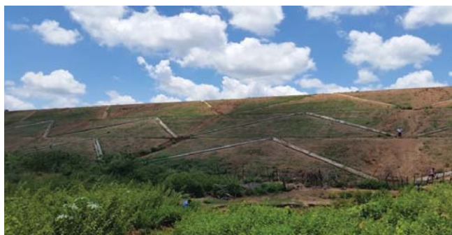
Foto 01: Vista de jusante para barragem.
