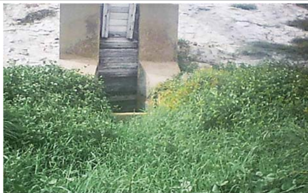
Foto 02: Galeria da tomada d'agua - acesso à comporta.
