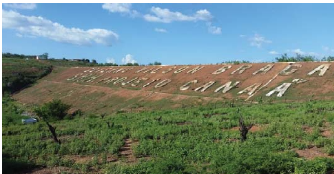
Foto 01: Vista de jusante para barragem principal.
