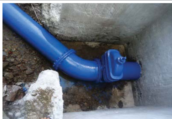
Foto 02: Tomada d'água - liberação para jusante.
