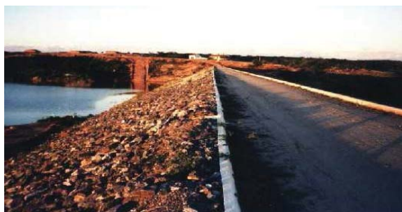
Foto 02: Detalhe do paramento de montante. (Fonte: http://atlas.srh.ce.gov.br/ )
