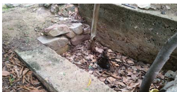
Foto 02: Tomada d'água a jusante da barragem.
