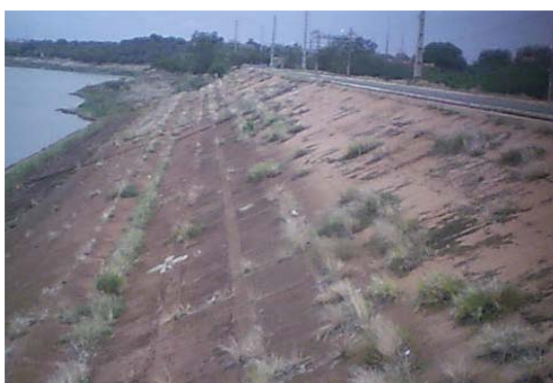
Foto 01: Detalhe do paramento de montante.
