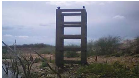
Foto 02: Torre de comando não finalizada.
