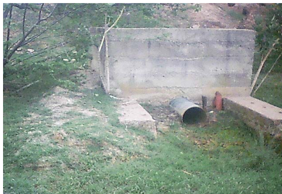
Foto 02: Tomada d'água - liberação para jusante.
