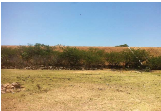
Foto 01: Vista de jusante para barragem.
