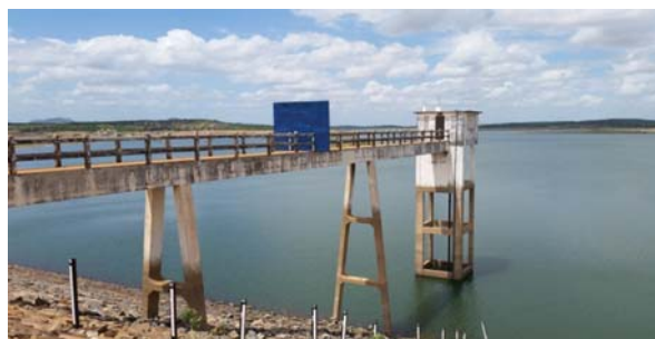
Foto 02: Torre de acionamento da comporta da tomada d'água.
