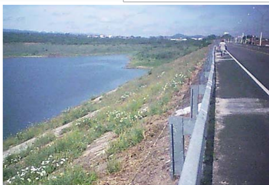
Foto 01: Paramento de montante com vegetação.
