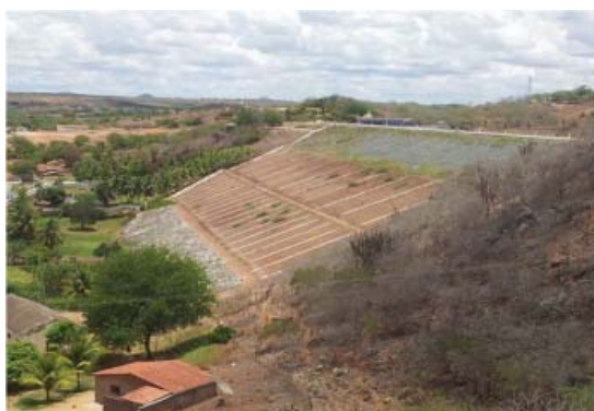
Foto 01: Vista de jusante para barragem principal.
