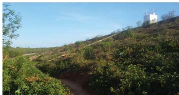
Foto 01: Detalhe do paramento de jusante.
