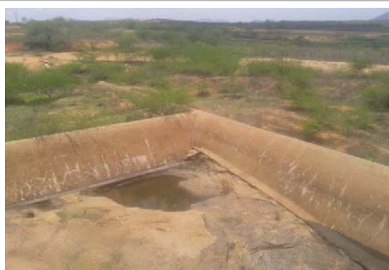
Foto 02: Ponte vertedoura - Perfil Creager.
