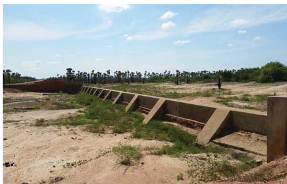
Foto 02: Vertedouro.
