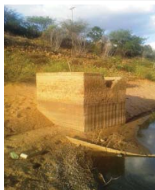
Foto 02: Tomada d'água a montante da barragem.
