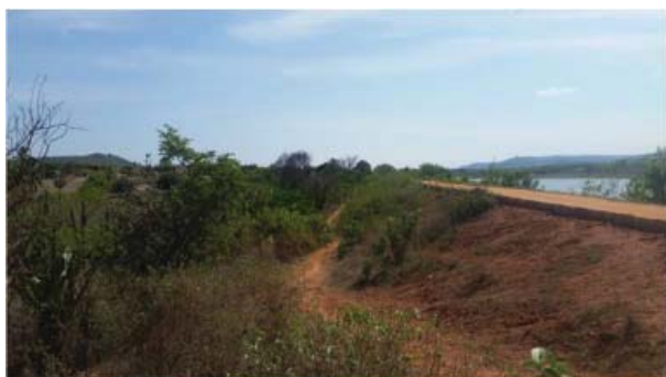
Foto 01: Vista da barragem a partir de jusante.
