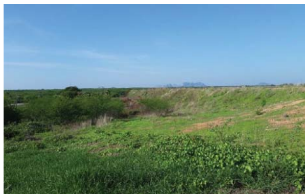
Foto 01: Vista da barragem a partir de jusante.
