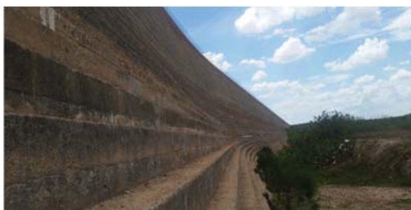
Foto 01: Detalhe do paramento de jusante.
