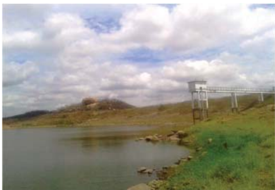
Foto 01: Barragem principal. Torre de comando à direita.
