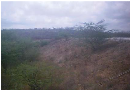
Foto 01: Vista de jusante para a barragem.
