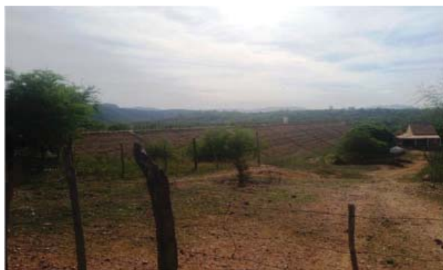
Foto 01: Vista de jusante para a barragem.
