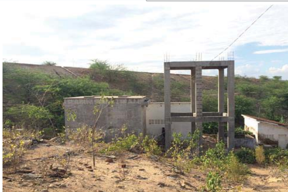
Foto 01: Vista de jusante para barragem principal.
