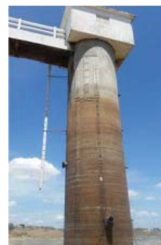
Foto 02: Torre com marcação de nível no corpo de concreto.
