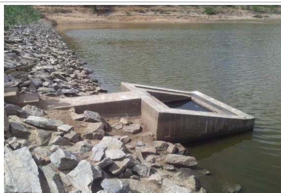
Foto 02: Estrutura da tomada d'água a montante.
