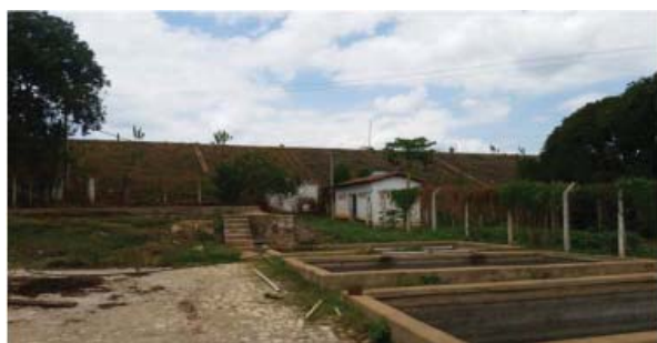
Foto 01: Vista para a barragem principal a partir de jusante.
