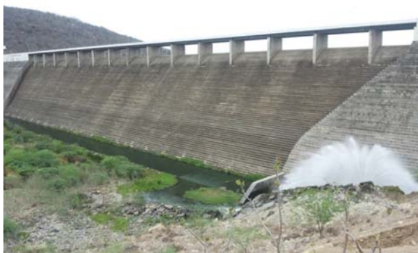
Foto 01: Vista de jusante para a barragem.
