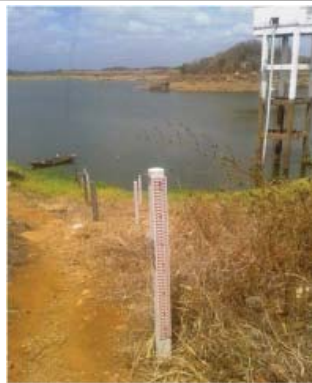
Foto 02: Conjunto de réguas no reservatório
