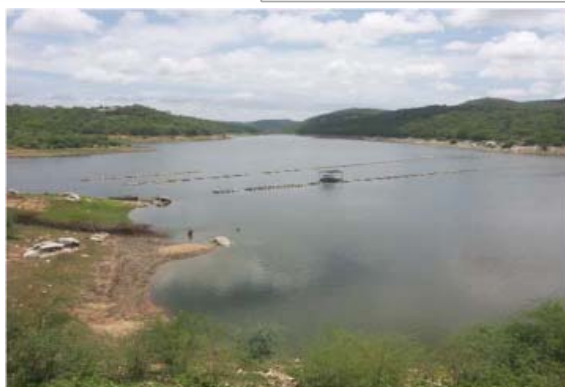
Foto 01: Vista da barragem para montante.
