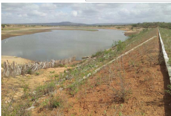
Foto 01: Detalhe do paramento de jusante.
