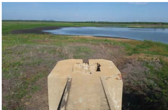
Foto 02: Torre de comando.
