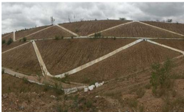
Foto 01: Vista de jusante para barragem.
