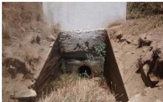
Foto 02: Detalhe da tomada d'água de liberação para jusante.
