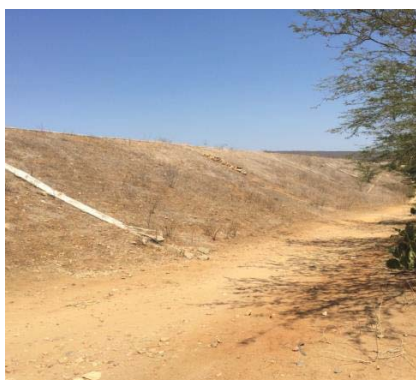
Foto 01: Detalhe do paramento de jusante.
