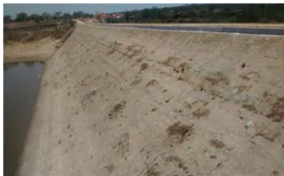
Foto 01: Detalhe do paramento de montante.
