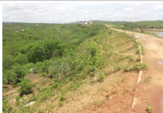
Foto 02: Detalhe do paramento de jusante.
