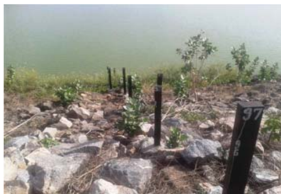
Foto 02: Conjunto de réguas no paramento de montante.
