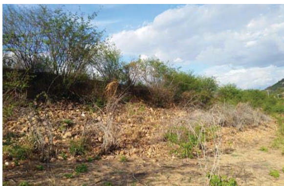
Foto 01: Paramento de montante.
