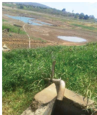
Foto 02: Captação provisória (CAERN) - Jan/2015
