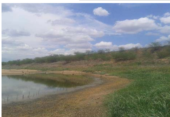
Foto 01: Vista de montante para barragem.
