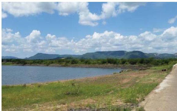
Foto 01: Vista da barragem a partir de montante.
