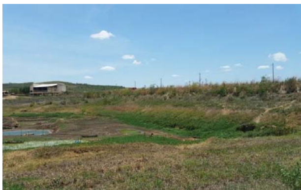
Foto 01: Paramento de montante.
