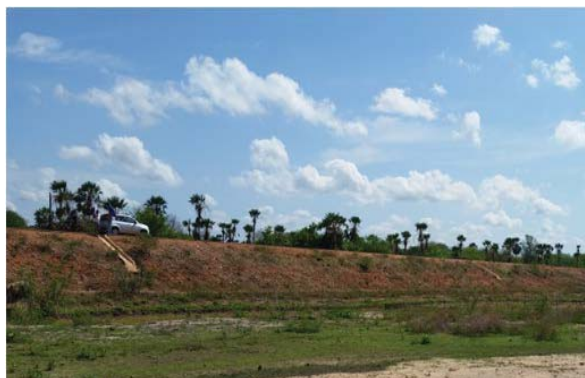
Foto 01: Vista de montante para barragem.
