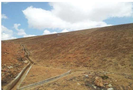
Foto 01: Paramento de jusante.
