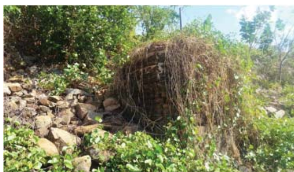
Foto 02: Torre de comando.
