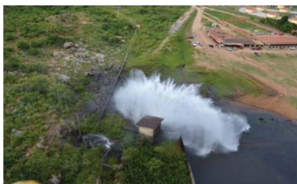
Foto 02: Tubulação da tomada d'água e válvula dispersora.
