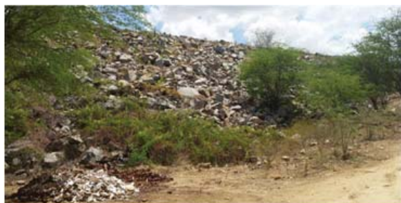
Foto 01: Paramento de jusante.
