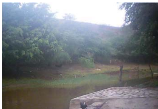
Foto 01: Vista de jusante para a barragem.
