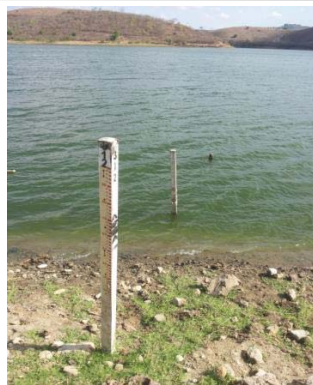
Foto 02: Conjunto de réguas linimétricas.
