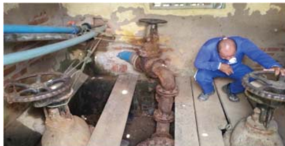
Foto 02: Derivações tomada d'água da barragem.
