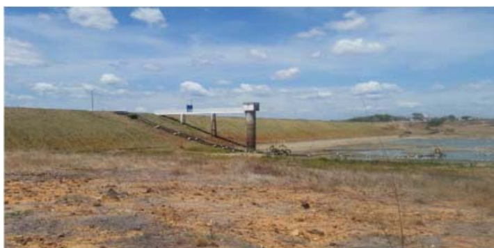
Foto 01: Vista de montante para barragem com torre de comando.
