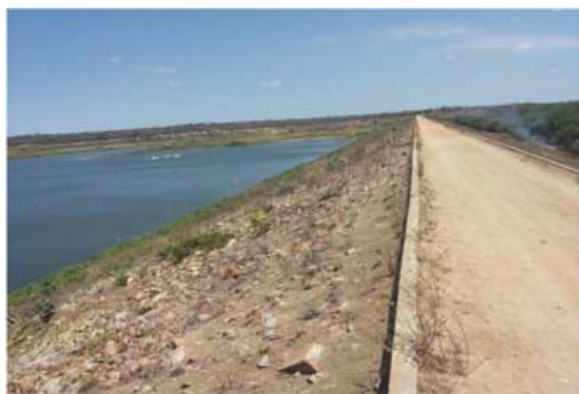
Foto 01: Vista do paramento de montante.
