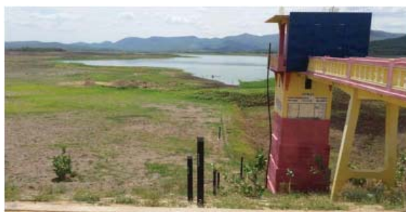
Foto 02: Régua linimétrica e torre de comando.
