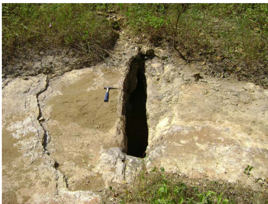
Foto 2.26 – Fissura alargada pela movimentação da água gerando sumidouro na Formação Jandaíra. Estrutura alinhada 310 Az. (ANA-40:654676,9429858).
