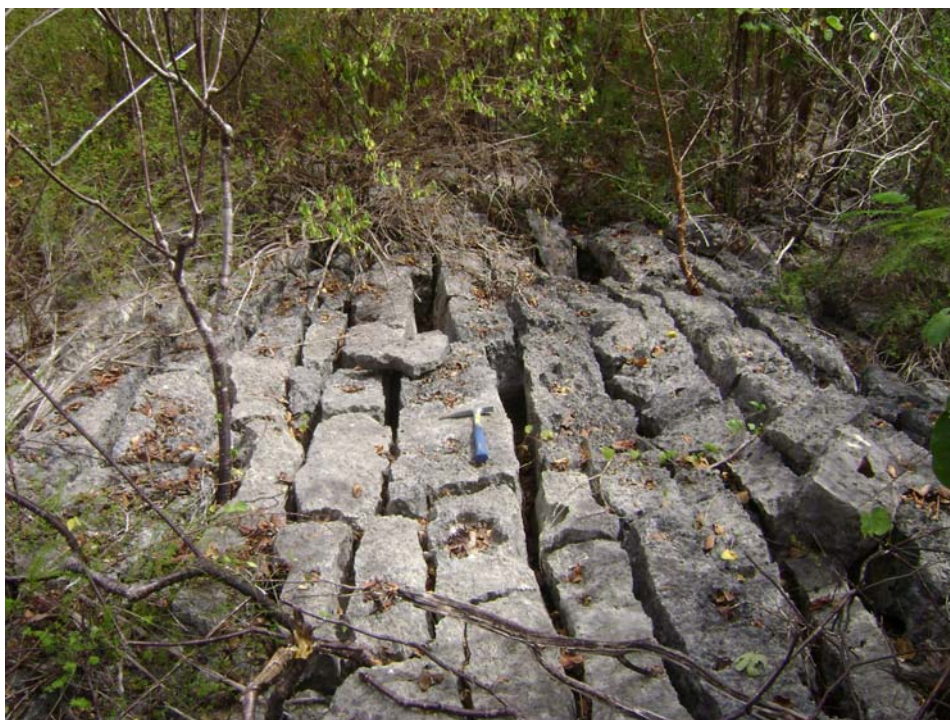
Foto 2.16 – Fraturas extensivas principais (NW-SE) conectadas ortogonalmente às secundárias, Calcário Jandaíra, Lajedo Mato Alto (ANA-46; 638700, 9436100).
