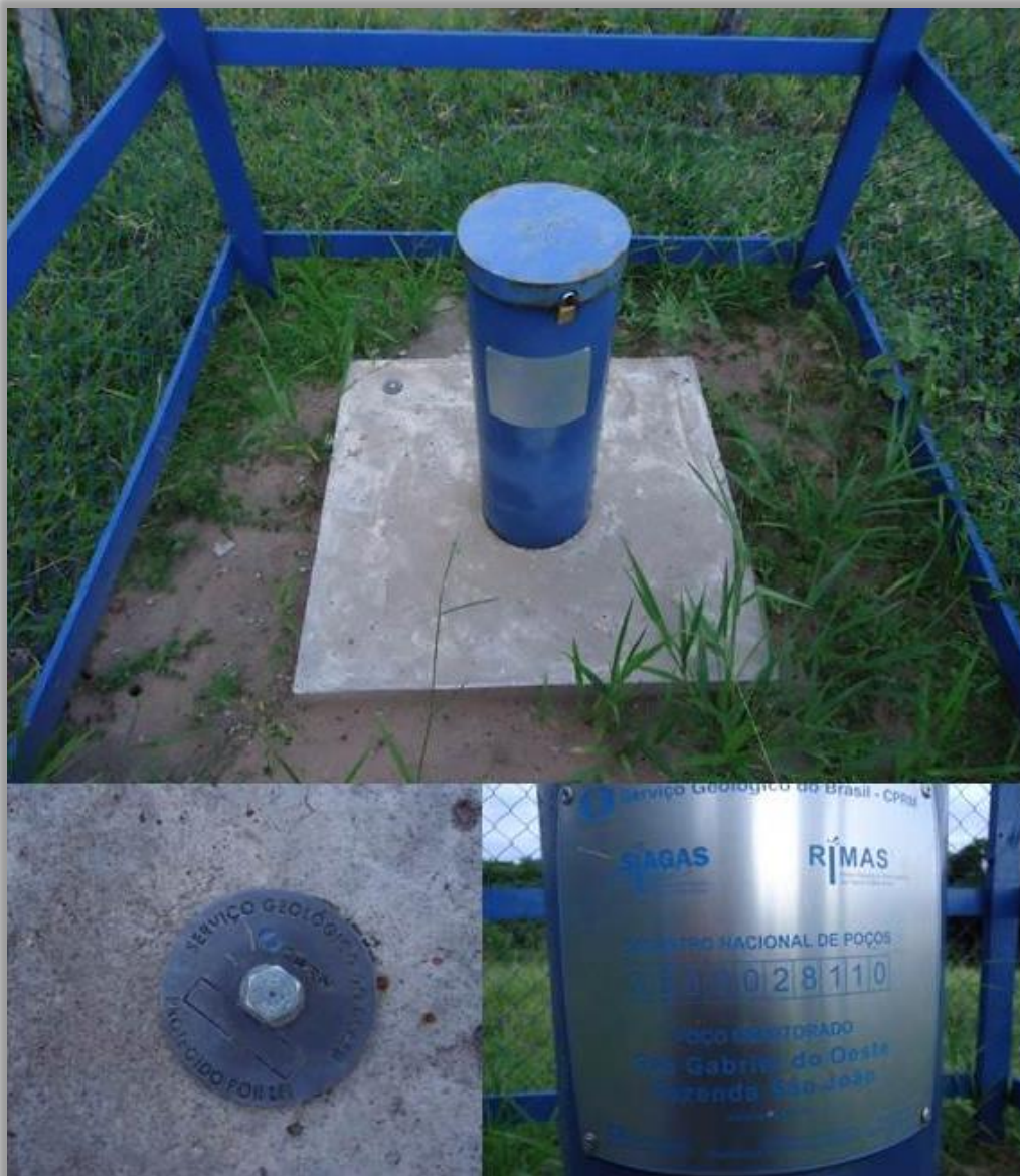
Figura 3.1 - Poço no Rio Grande do Sul pertencente à Rede Nacional Integrada de Monitoramento de Águas Subterrâneas – RIMAS – CPRM
