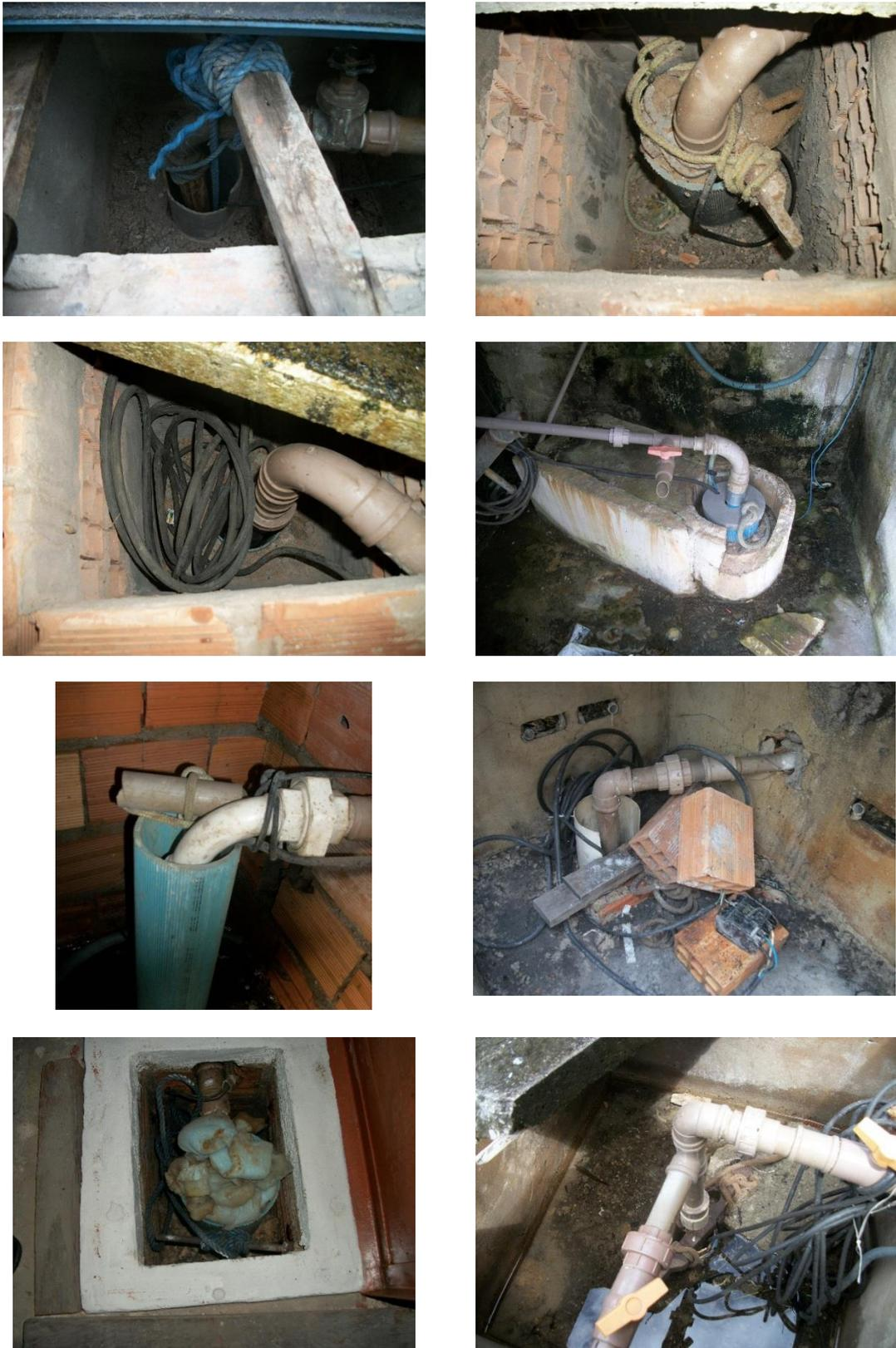
Figura 2 – Exemplos de desconformidades encontradas em poços cadastrados na região de Belém.
