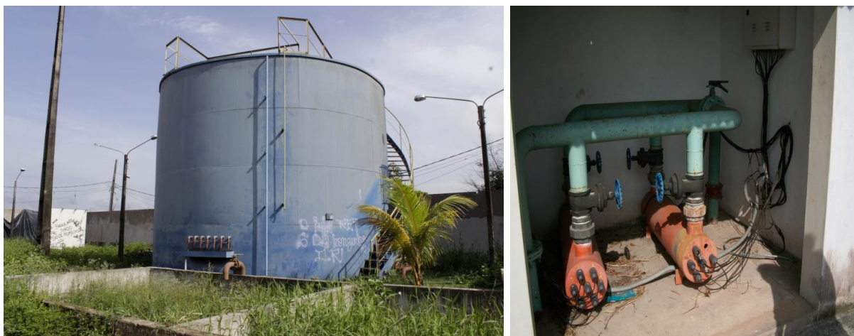
Figura 26 – ETE Vila da Barca, em Belém. Fonte: COSANPA
