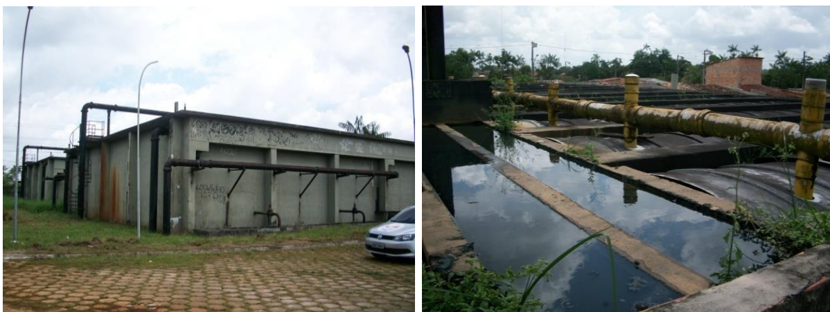
Figura 25 – ETE Coqueiro, em Belém. Fonte: PMB (2014).
