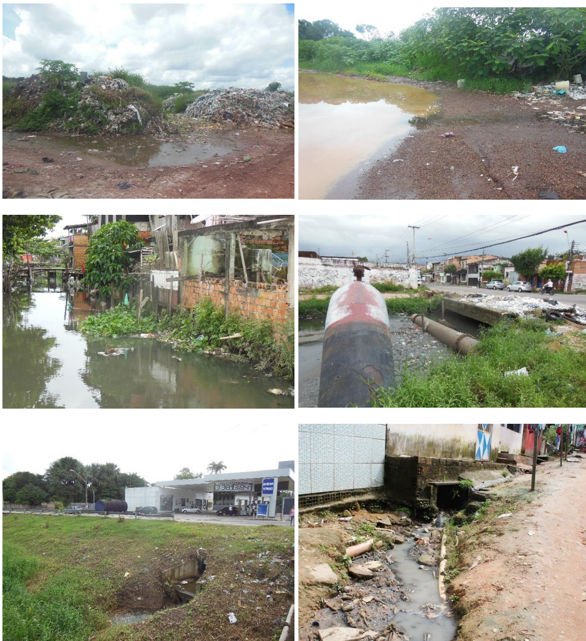
Figura 27 – Contaminação do solo e corpos hídricos devido à carência de saneamento básico na região de Belém.
