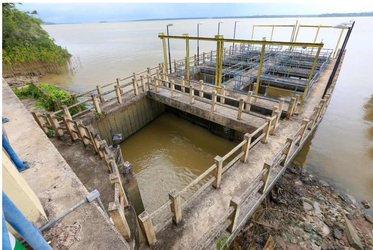
Figura 5 – Captação de água no rio Guamá para reforço dos lagos Água Preta e Bolonha.
