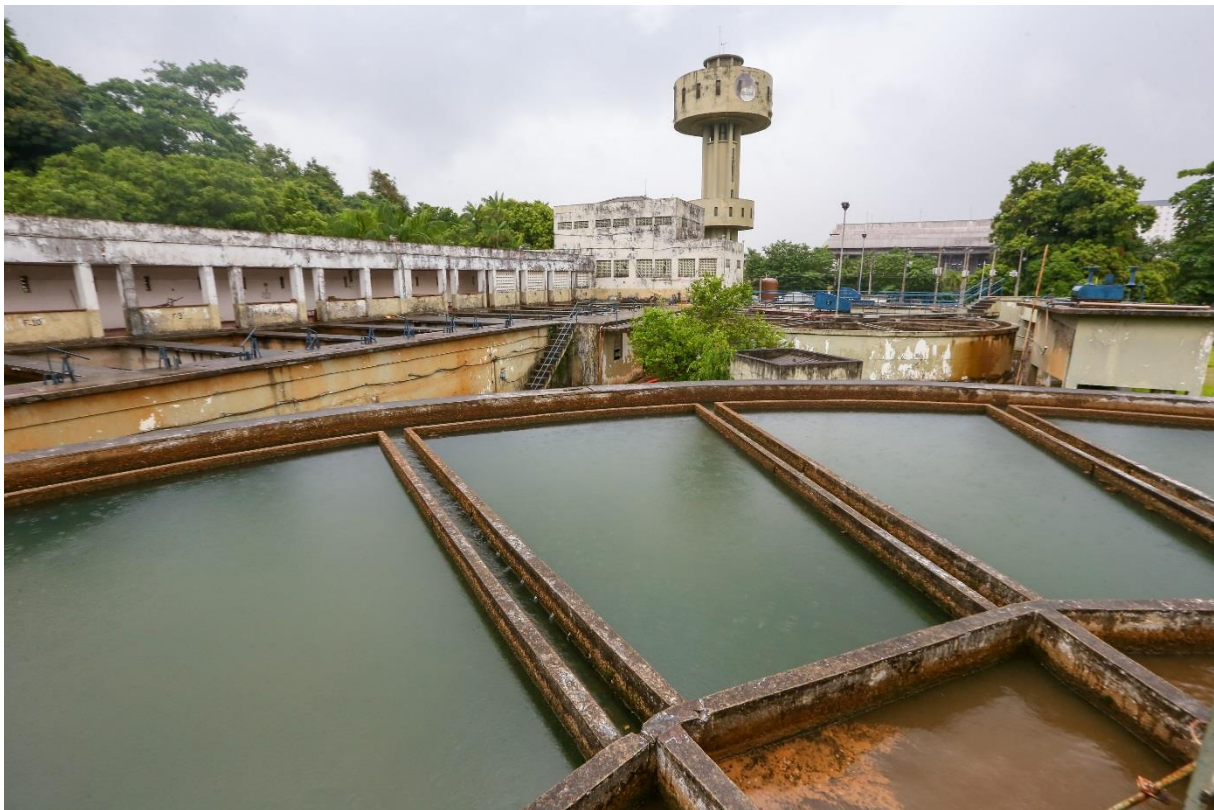
Figura 11 – ETA e Reservatório Elevado 5º Setor.
