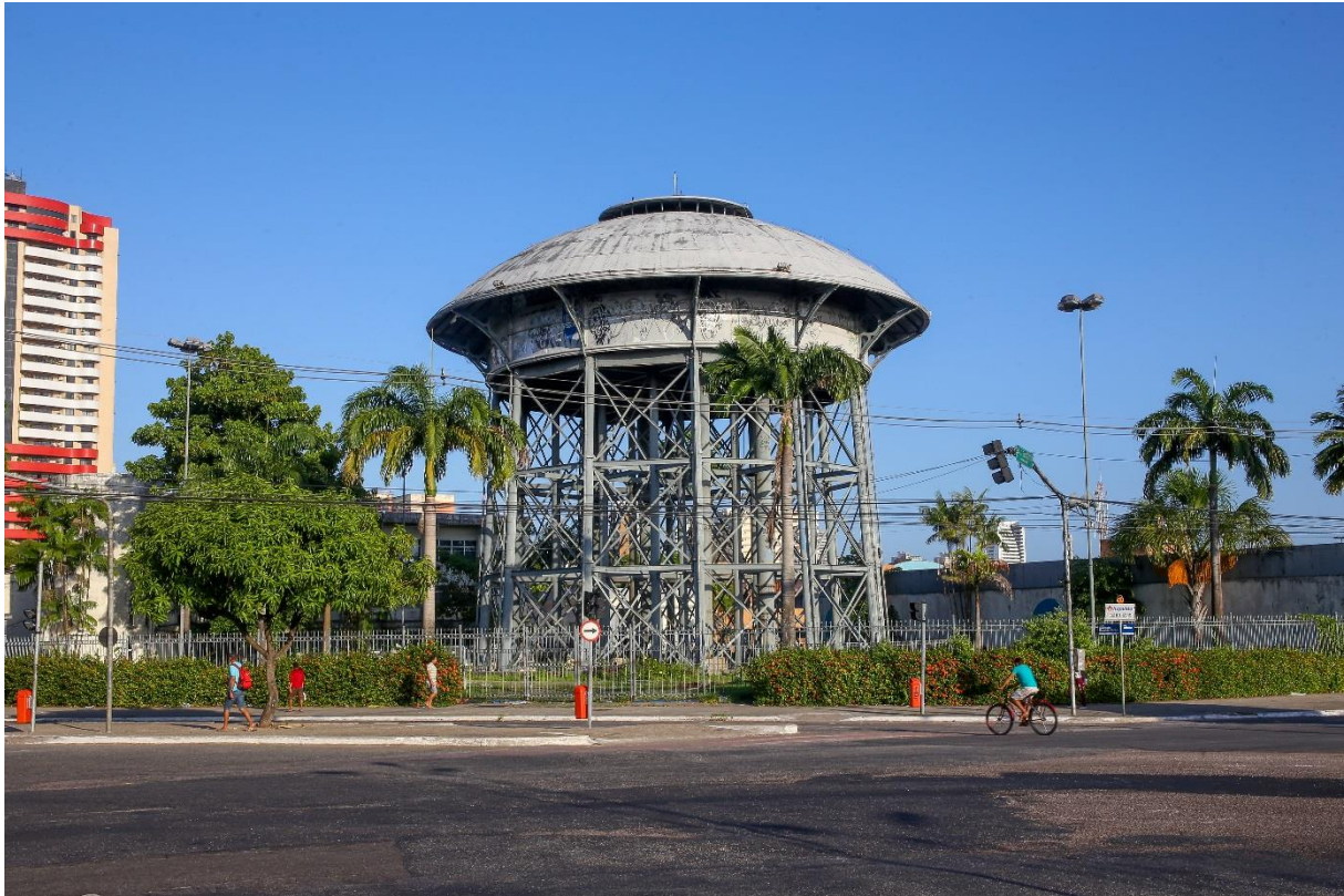
Figura 10 – Reservatório São Brás.
