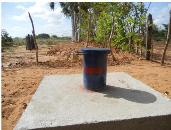
PE Extremoz – acabamento construtivo e marca do nivelamento topográfico
