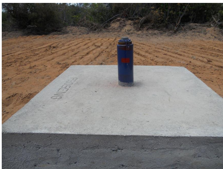
PO-01 Ceará Mirim – acabamento construtivo e marca da ranhura do nivelamento topográfico
