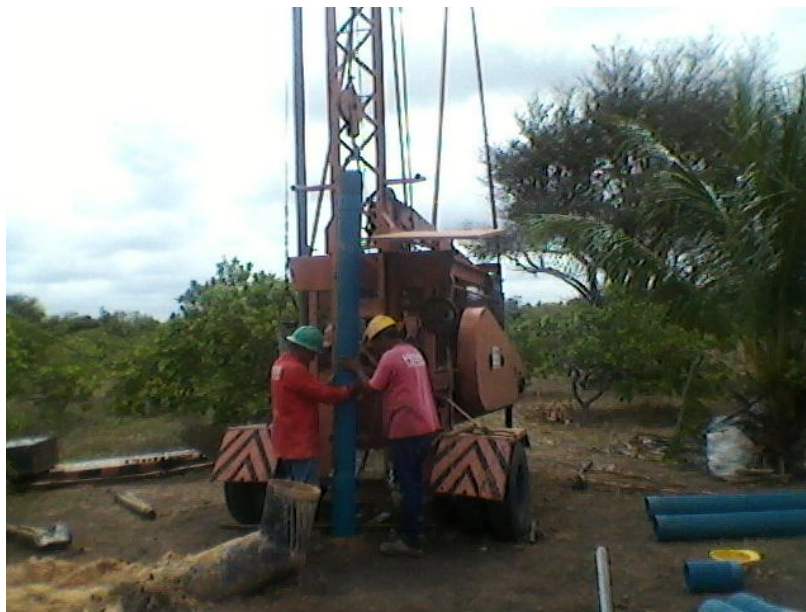
Descida do revestimento no PE
