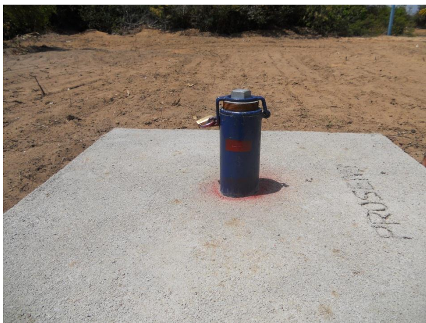
PO-02 Ceará-Mirim – acabamento construtivo e marca da ranhura do nivelamento topográfico
