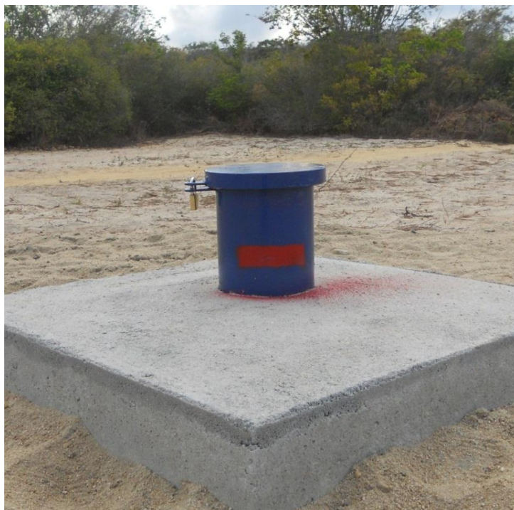
Poço exploratório de Nísia Floresta concluído, tubo de fechamento e marca da ranhura do nivelamento topográfico
