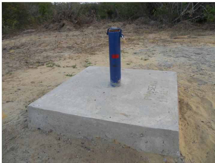
PO-01 Nísia Floresta – acabamento construtivo e marca da ranhura do nivelamento topográfico
