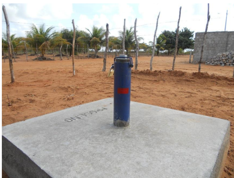
PO-01 Extremoz – acabamento construtivo e marca da ranhura do nivelamento topográfico
