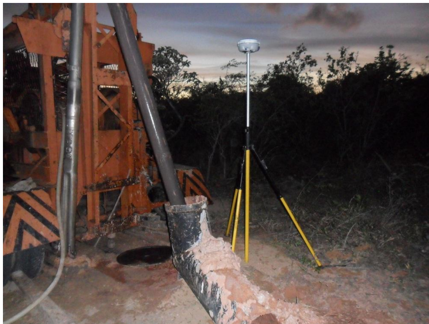
PO-02 Ceará Mirim - nivelamento topográfico com GPS geodésico
