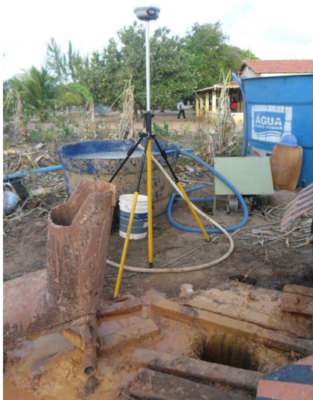
PO-01 Ceará-Mirim - nivelamento topográfico com GPS geodésico
