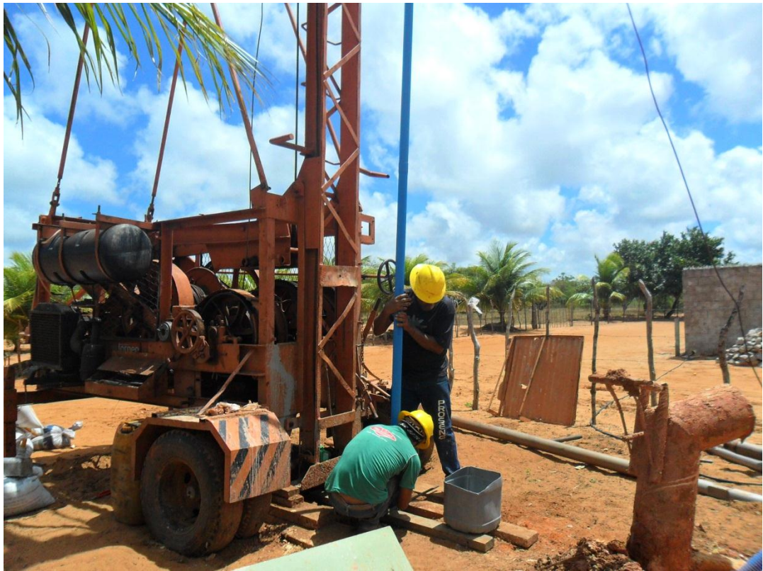
Revestimento do PO 01
