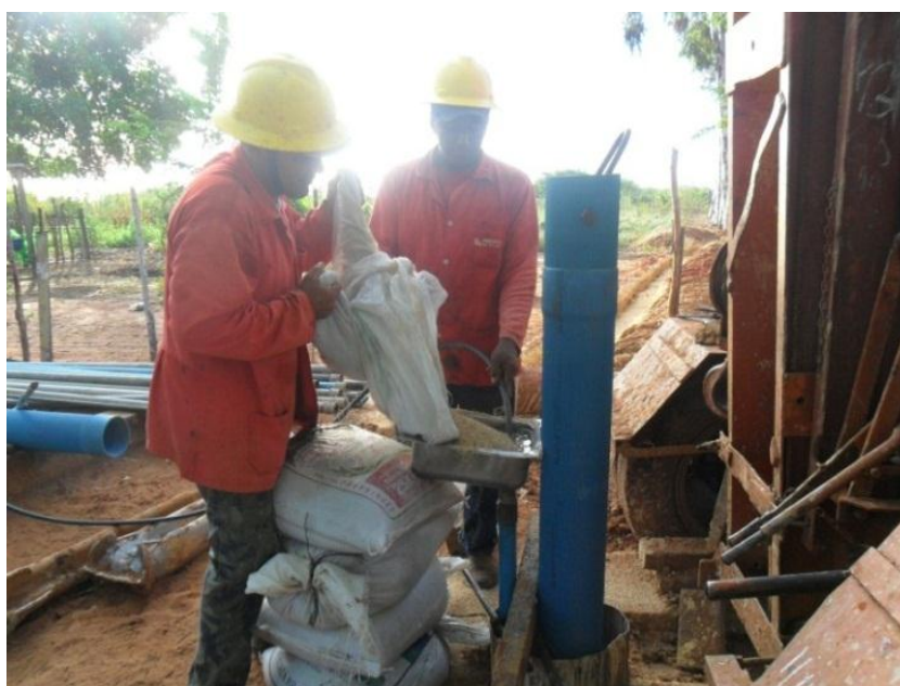
Aplicação do pré-filtro no PE utilizando tubo auxiliar
