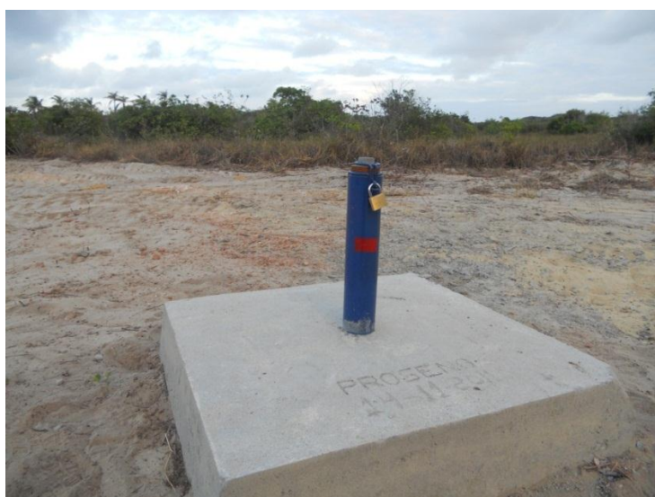
PO-02 Nísia Floresta – acabamento construtivo e marca da ranhura do nivelamento topográfico
