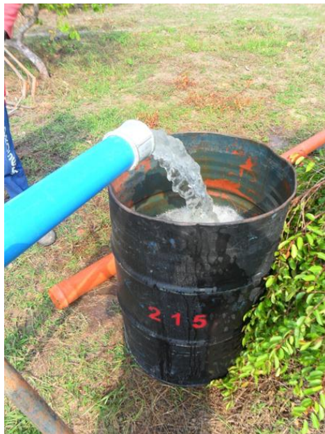
Teste de bombeamento: - medição de vazão com tambor aferido 215 l
