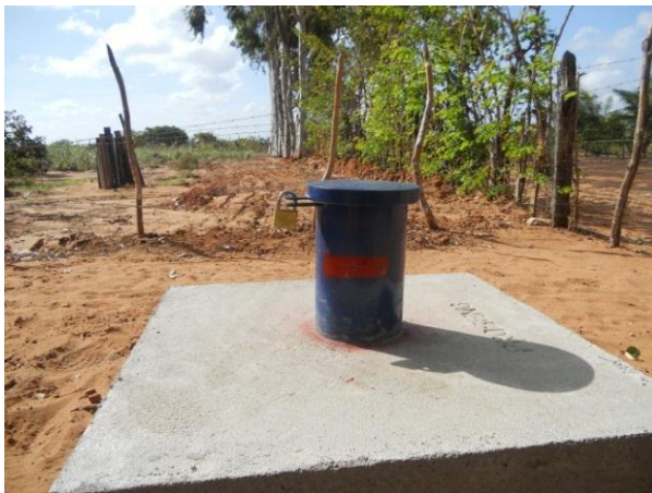
Foto 12. PE Loteamento Caminho do Mar – Extremoz: acabamento construtivo e marca do nivelamento topográfico
