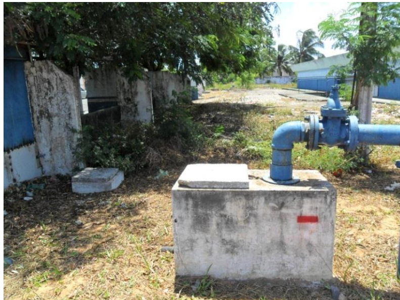
Foto 21. Marca de sinalização do entalhe do nivelamento topográfico
