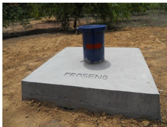
Foto 10. PE Faz. São Mateus - Ceará-Mirim: acabamento construtivo e marca da ranhura do nivelamento topográfico
