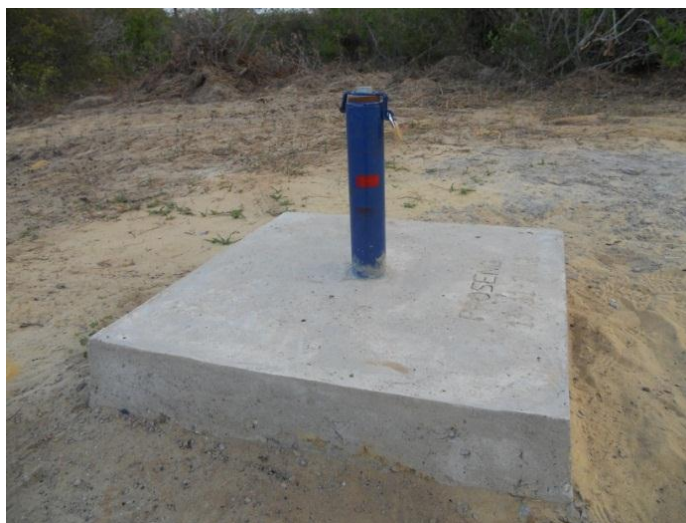
Foto 7. PO-01 da Lagoa Amarela - Nísia Floresta: acabamento construtivo e marca da ranhura do nivelamento topográfico
