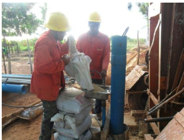
Foto 13. Aplicação do pré-filtro no PE utilizando tubo auxiliar
