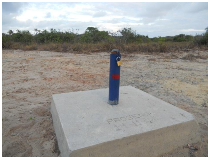
Foto 8. PO-02 da Lagoa Amarela - Nísia Floresta: acabamento construtivo e marca da ranhura do nivelamento topográfico
