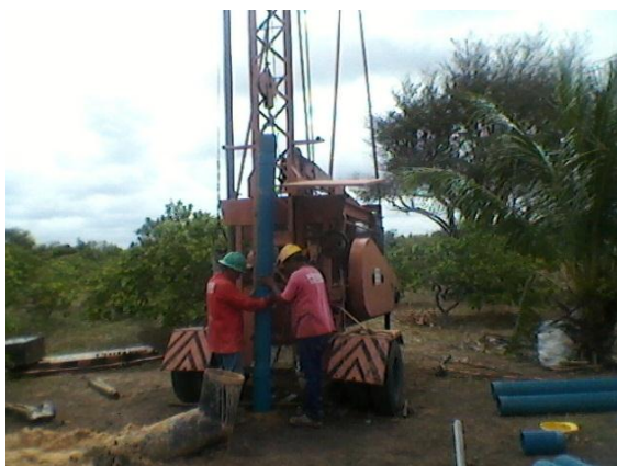
Foto 9. Descida do revestimento no PE da Fazenda São Mateus – Ceará-Mirim
