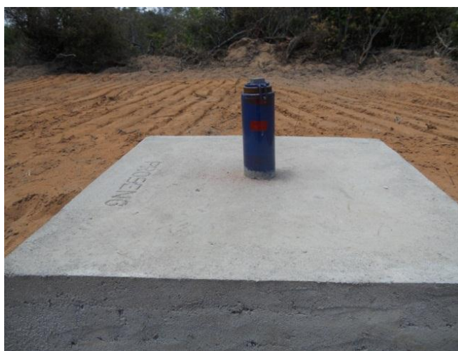
Foto 11. PO-01 Fazenda São Mateus - Ceará-Mirim: acabamento construtivo e marca da ranhura do nivelamento topográfico
