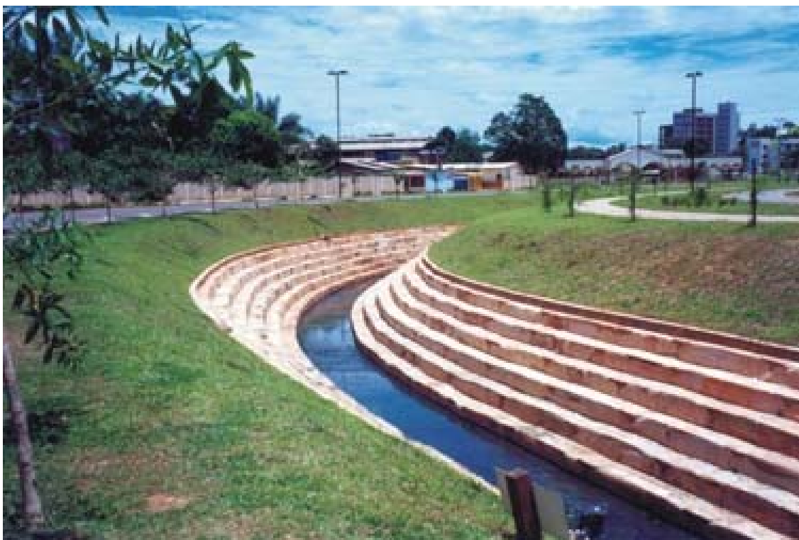
Foto 2.1 – Canal da Maternidade no centro de Rio Branco.
