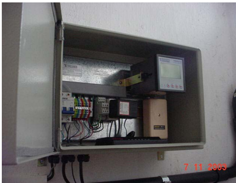
Figura 19.2 – Caixa de recepção dos sinais emitidos pelos sensores e de transmissão dos sinais para o centro de controle.
