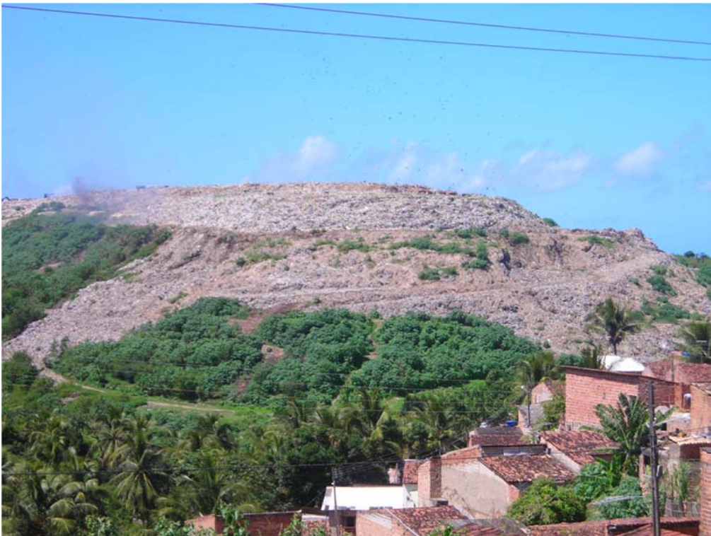
Figura 12.18 - Aterro de lixo da cidade de Maceió.
