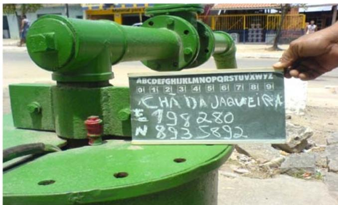
**Figura 7.10** - Poço instalado com bomba em que foi colocado o tubo guia (em vermelho) para medição do nível estático.
