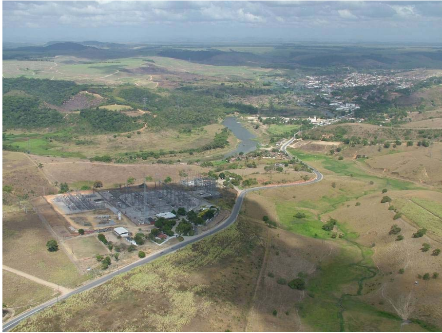
Figura 5.44 - Subestação de energia elétrica em Rio Largo em meio a canaviais e pastos, tendo ao fundo o rio Mundaú.
