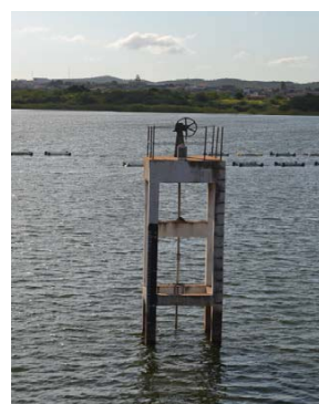
Foto 02: Torre de controle da comporta da tomada d'água.
