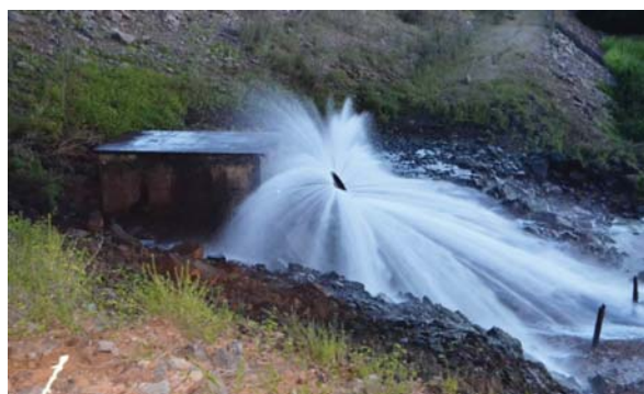
Foto 02: Válvula dispersora - liberação para jusante.
