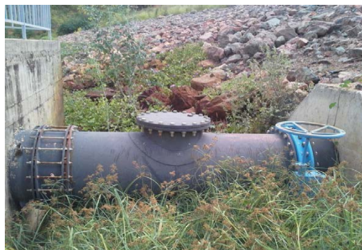
Foto 02: Tubulação da tomada d'água.
