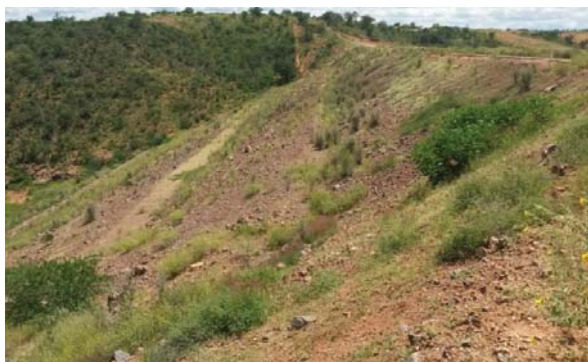
Foto 01: Paramento de jusante.
