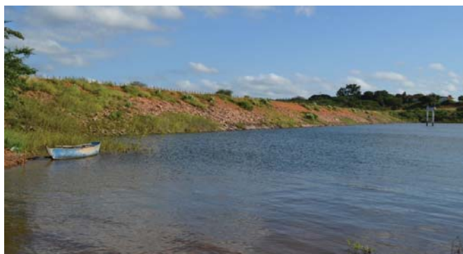
Foto 01: Vista de montante para a barragem.
