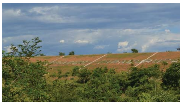
Foto 01: Vista de jusante para a barragem.
