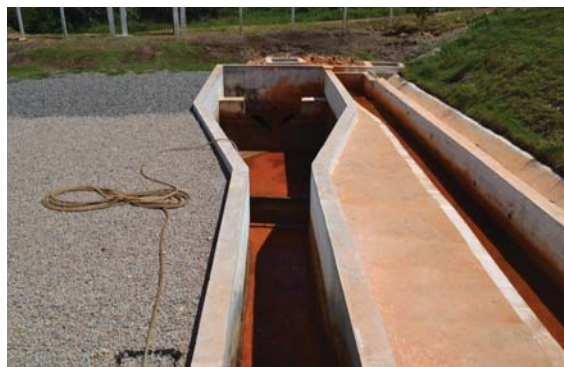
Foto 02: Calha Parshall a jusante da liberação de água.
