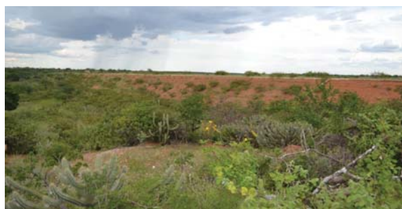
Foto 01: Vista de jusante para a barragem.
