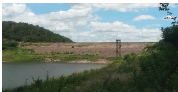
Foto 01: Vista de montante para a barragem.
