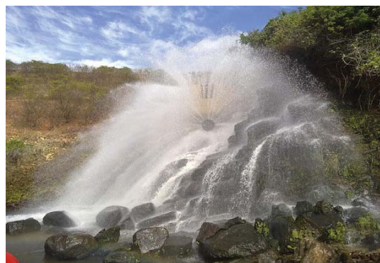
Foto 02: Detalhe da válvula dispersora. (Fonte: Google Earth)
