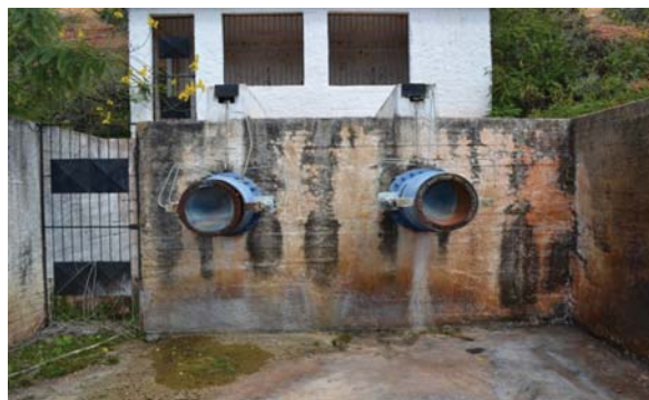
Foto 02: Válvulas dispensoras e casa de controle.
