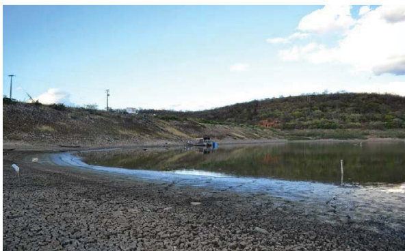
Foto 01: Vista de montante para barragem. (Fonte: http://jesusdacosta.blogspot.com.br/ )
