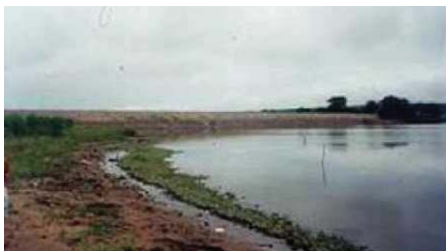
Foto 02: Vista de montante para a barragem. (Fonte: http://atlas.srh.ce.gov.br/ )
