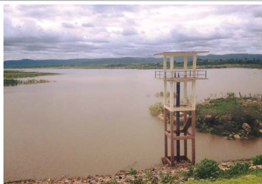
Foto 02: Detalhe da torre de comando da tomada d'água. (Fonte: http://www.portaldohelvecio.com )
