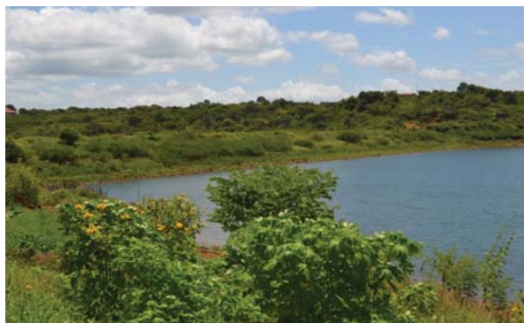
Foto 01: Vista de montante para barragem.
