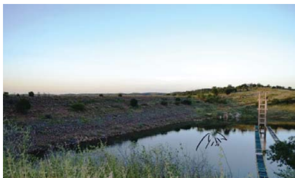
Foto 01: Vista de montante para a barragem.
