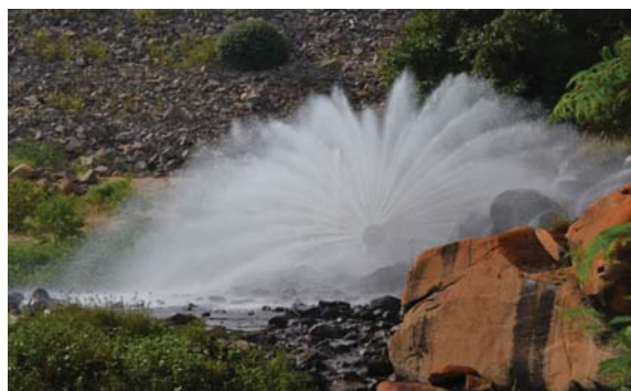
Foto 02: Liberação para jusante - válvula dispersora.
