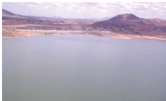
Foto 02: Vista de montante para a barragem. (Fonte: http://atlas.srh.ce.gov.br/ )
