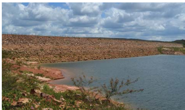
Foto 01: Detalhe do paramento de montante.
