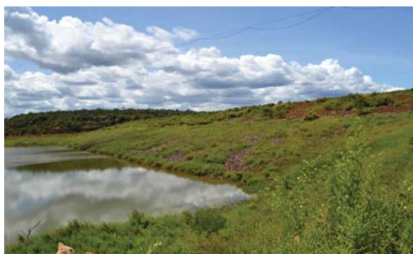
Foto 01: Vista de montante para barragem principal.
