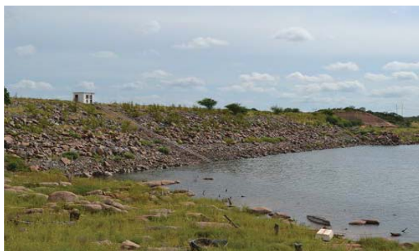
Foto 01: Detalhe do paramento de montante.
