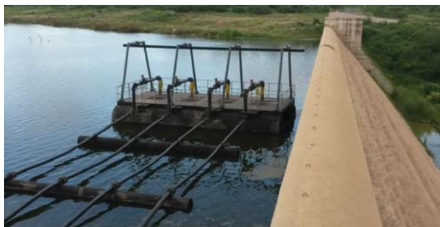
Foto 02: Captação flutuante do Sistema Adutor Sudeste Piauí.
