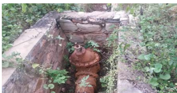
Foto 02: Registro gaveta na saída na tomada d'água.
