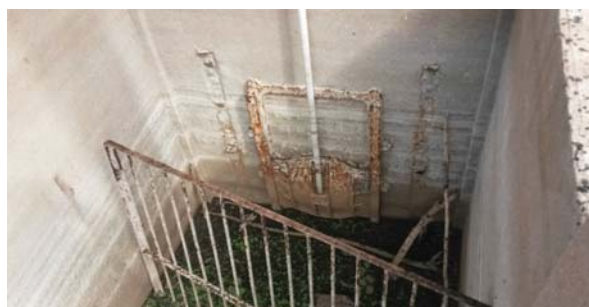
Foto 02: Comporta gaveta - tomada d'água.
