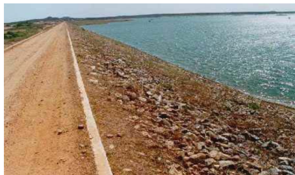
Foto 02: Vista da barragem para jusante. (Fonte: http://atlas.srh.ce.gov.br/ )
