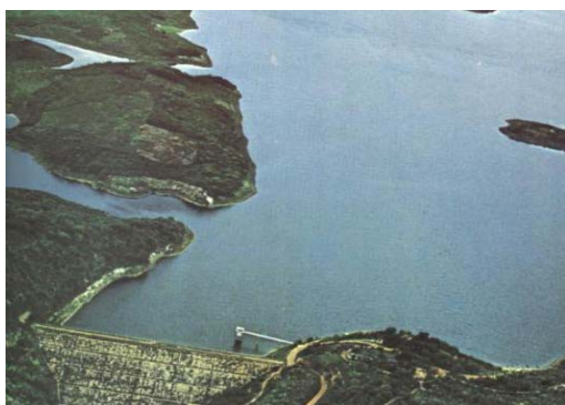
Foto 01: Vista aérea da barragem. (Fonte: http://atlas.srh.ce.gov.br/ )
