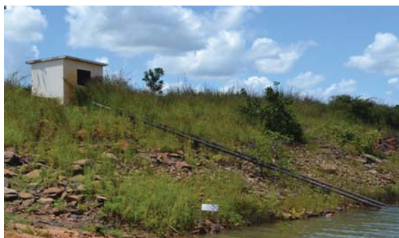
Foto 02: Casa e dutos de comando das comportas da tomada d'água.
