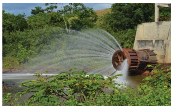
Foto 02: Válvula dispersora - liberação para jusante.
