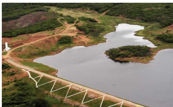
Foto 01: Vista aérea do corpo da barragem. (Fonte: http://externo.cogerh.com.br/Imagens/Arrebita.jpg )
