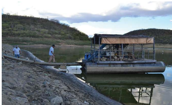
Foto 02: Detalhe de captação sobre flutuantes. (Fonte: http://jesusdacosta.blogspot.com.br/ )
