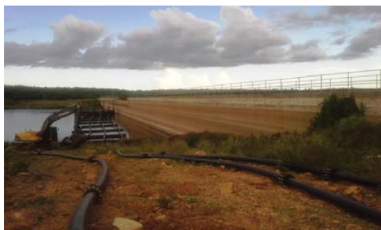
Foto 01: Detalhe do paramento de montante.
