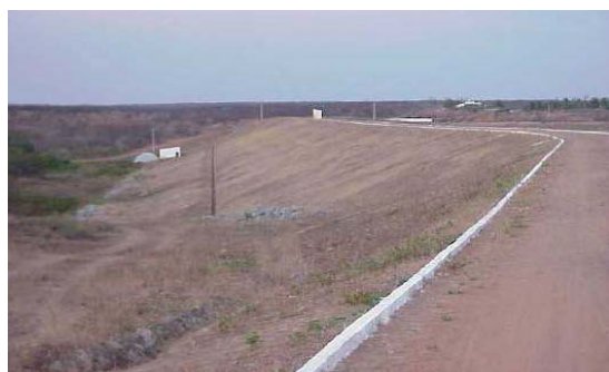
Foto 01: Detalhe do paramento de jusante (Fonte: http://atlas.srh.ce.gov.br/ )
