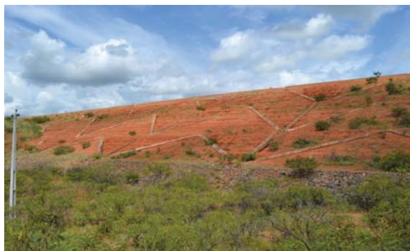
Foto 01: Vista de jusante para a barragem.
