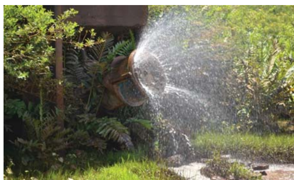
Foto 02: Válvula dispensora - liberação para jusante.
