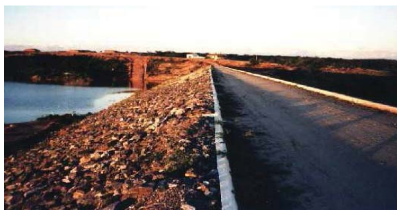
Foto 02: Detalhe do paramento de montante. (Fonte: http://atlas.srh.ce.gov.br/ )
