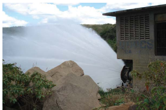
Foto 02: Detalhe da válvula dispersora. (Fonte: Google Earth)
