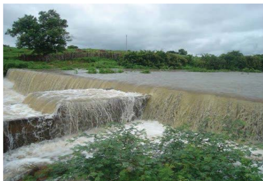
Foto 01: Vertedouro da barragem. (Fonte: Google Earth)
