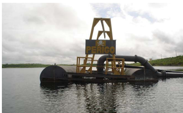
Foto 02: Captação sobre flutuantes - SAAE. (Fonte: Google Earth)
