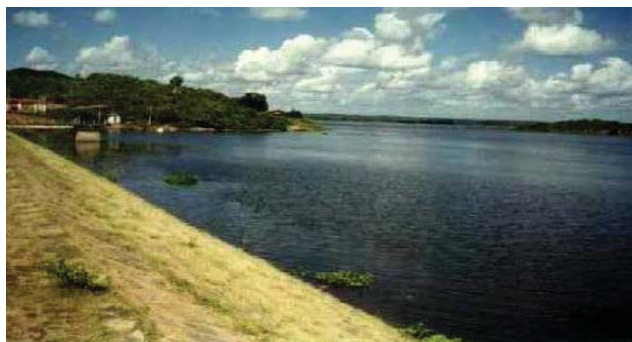
Foto 02: Vista da barragem para montante. (Fonte: http://atlas.srh.ce.gov.br/ )
