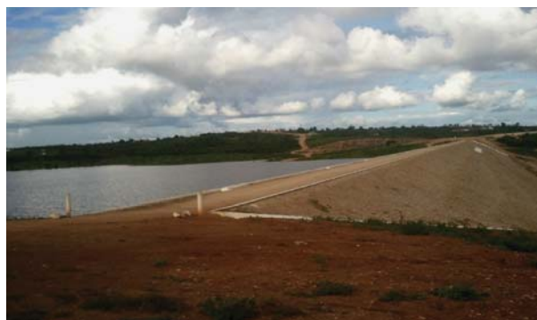
Foto 02: Detalhe do paramento de jusante. (Fonte: http://madalenaweb.blogspot.com.br )
