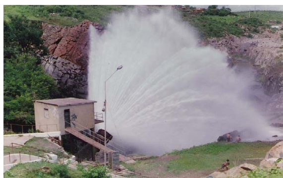
Foto 02: Detalhe da válvula dispersora. (Fonte: Google Earth)
