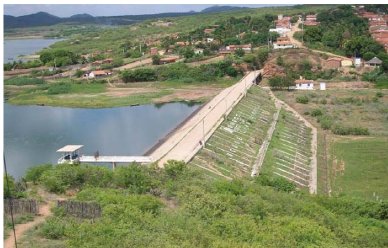
Foto 01: Vista da margem direita para barragem. (Fonte: Google Earth)
