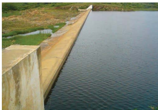
Foto 01: Vertedouro da barragem. (Fonte: Google Earth)
