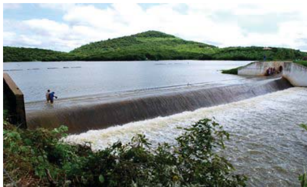
Foto 02: Vista do vertedouro. (Fonte: http://www.amtrapia1510.com.br/ )
