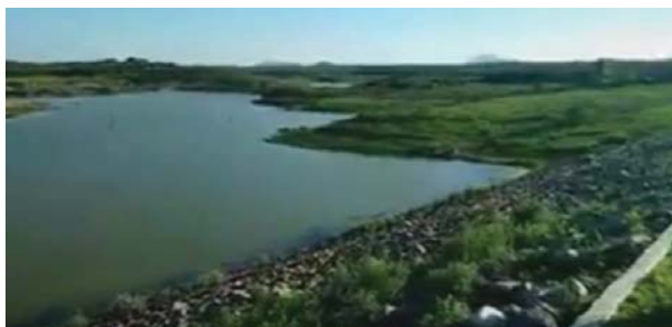
Foto 02: Detalhe do paramento de montante. (Fonte: https://www.youtube.com/watch?v=TT-Zc4N9KUs )
