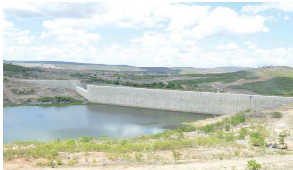
Foto 01: Vista de montante para barragem (Fonte: Google Earth)
