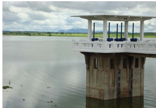
Foto 02: Torre de comando da tomada d'água. (Fonte: Google Earth)
