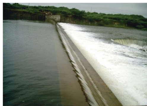
Foto 02: Vertedouro da barragem. (Fonte: Google Earth)
