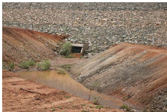
Foto 02: Detalhe da tomada d'água. (Fonte: Google Earth)
