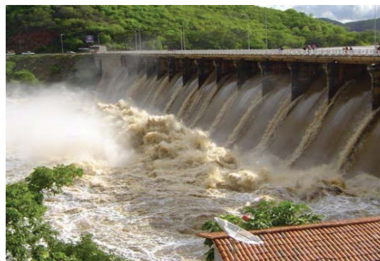
Foto 02: Vertedouro da barragem. (Fonte: Google Earth)
