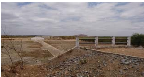
Foto 02: Vista do vertedouro da barragem. (Fonte: http://quixeramobimagora.blogspot.com.br/ )
