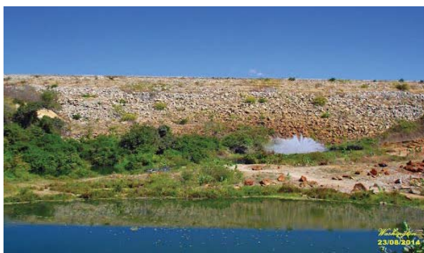
Foto 01: Vista de jusante para barragem. (Fonte: Google Earth)
