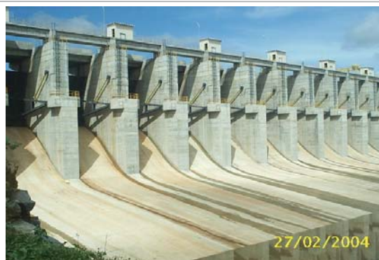
Foto 02: Detalhe das comportas do vertedouro. (Fonte: Google Earth)
