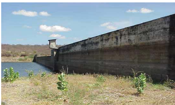
Foto 01: Vista lateral do corpo da barragem. (Fonte: http://ascom.cogerh.com.br/ )
