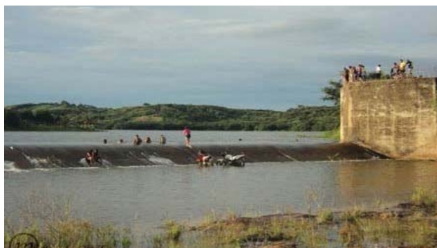
Foto 02: Vertedouro da barragem. (Fonte: http://coisasdenossaterra.blogspot.com.br/ )
