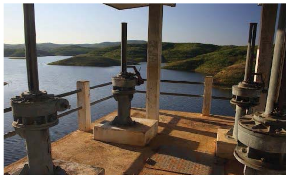
Foto 02: Estruturas de controle da torre de comando. (Fonte: Google Earth)
