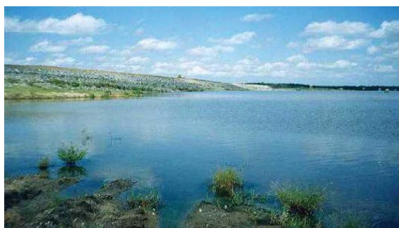
Foto 01: Vista de montante para a barragem. (Fonte: http://atlas.srh.ce.gov.br/ )
