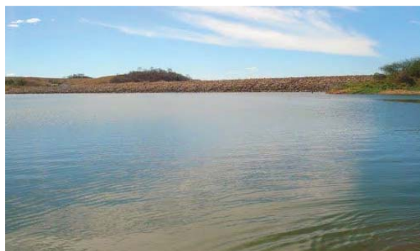
Foto 01: Vista de montante para a baragem. (Fonte: Google Earth)
