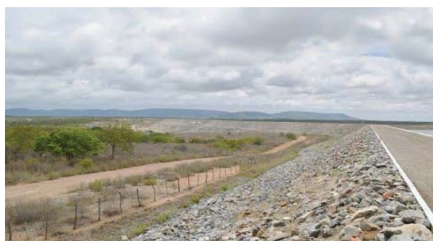
Foto 02: Vista da barragem para jusante. (Fonte: Google Earth)
