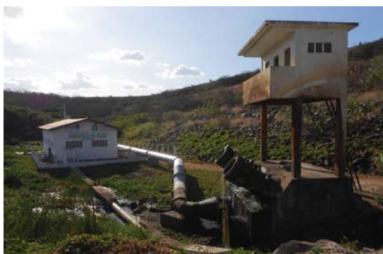
Foto 02: Tomada d'água - liberação para jusante. (Fonte: http://blogs.diariodonordeste.com.br/ )
