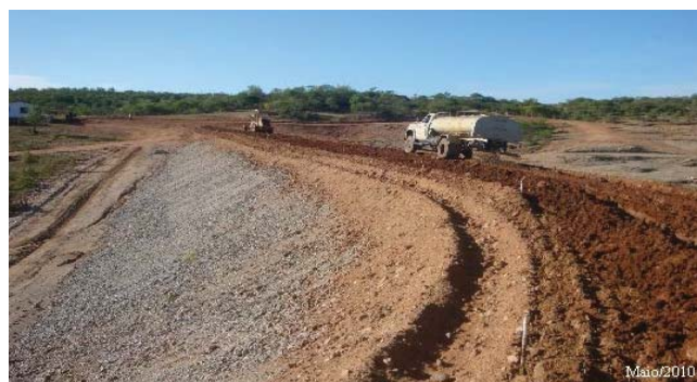
Foto 01: Coroamento da barragem (em construção) Fonte: http://atlas.srh.ce.gov.br/
