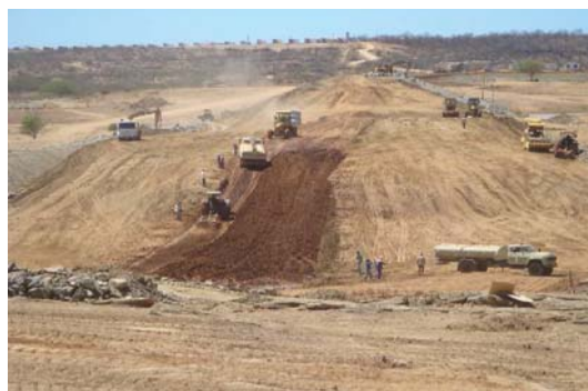
Foto 02: Vista geral do maciço terroso (em construção) Fonte: http://atlas.srh.ce.gov.br/
