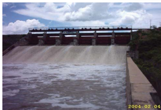
Foto 02: Vertedouro da barragem. (Fonte: Google Earth)
