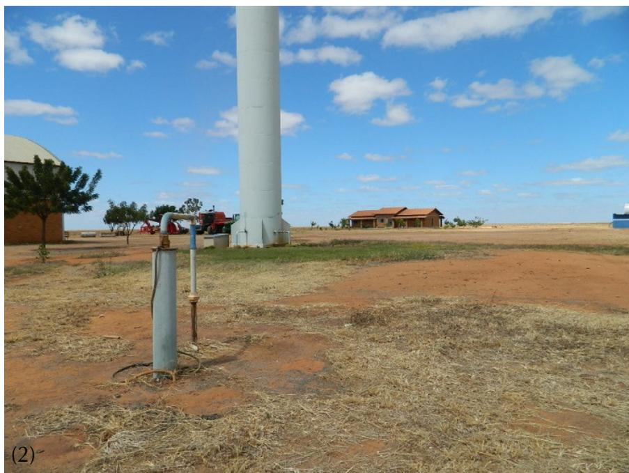
**Figura 10.17 - Exemplos de poços tubulares utilizados na região (1) Poço utilizado para irrigação e (2) Poço tubular utilizado para abastecimento humano.**
