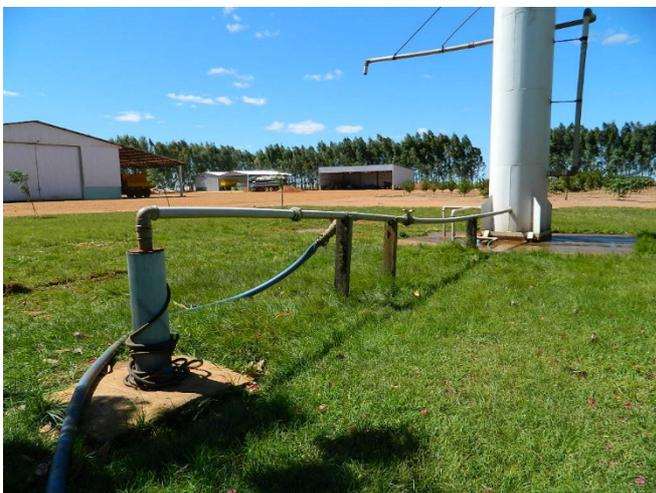
**Figura 7.9 - Poço tubular utilizado para captação de água subterrânea no SAU (\*oeste baiano).**
