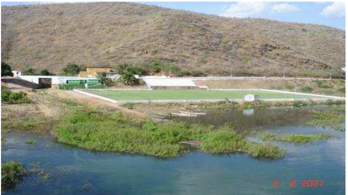
Foto 2 - Campo de futebol do Estádio José Ventura em Piranhas/AL, no dia 02/02/2007, com vazão de 3.699m 3 /s.
