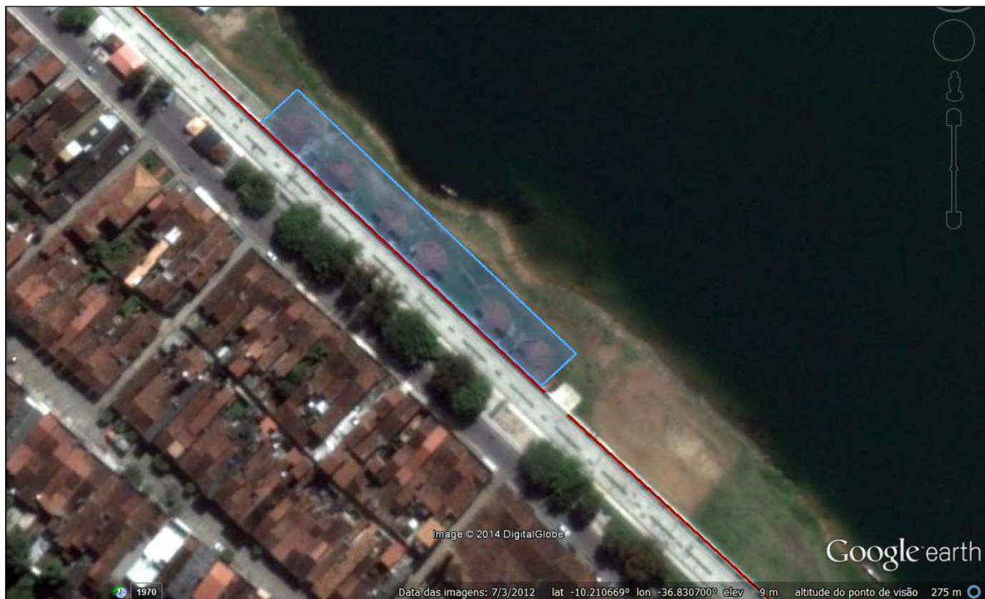
Figura 22- Bares sujeitos a inundação, localizados abaixo do cais de Proteção da Cidade de Propriá/SE, delimitados pelo polígono em azul.
