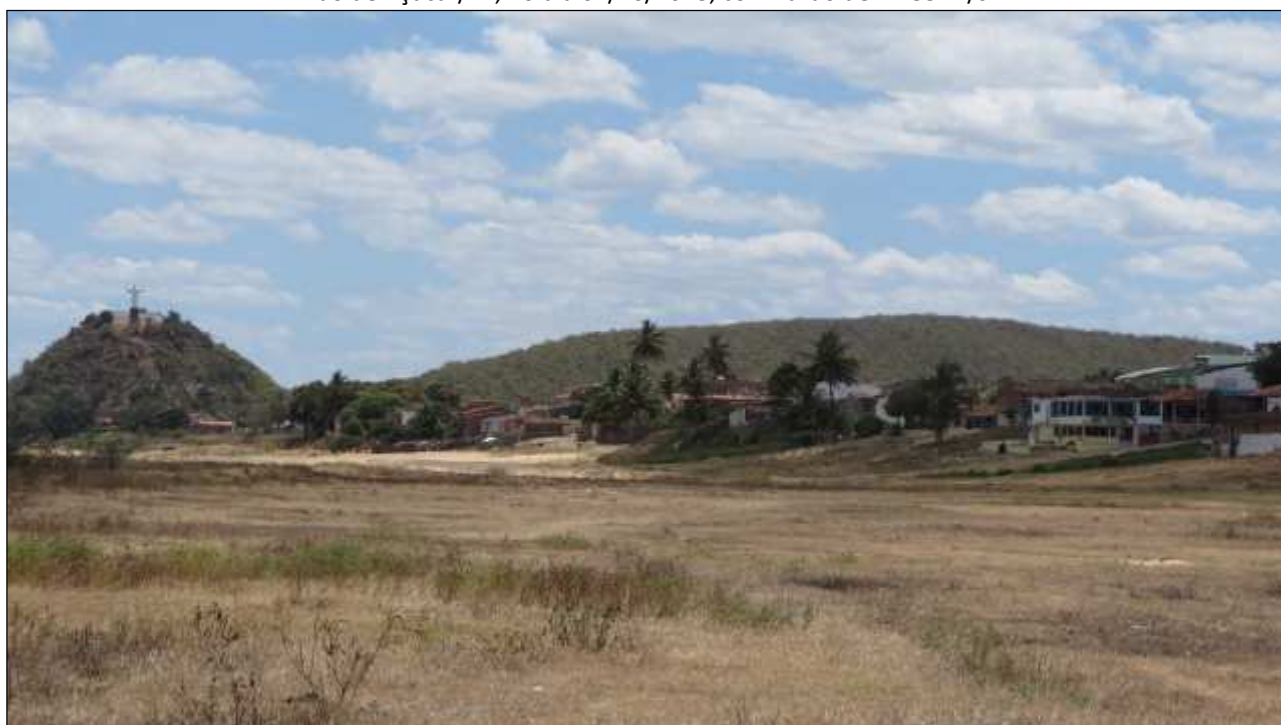
Foto 5- Casas passíveis de Inundação a partir de 4.000 \text{ m}^3/\text{s} , abaixo da cota da Rua Povoado Campo Alegre, a montante do centro de Pão de Açúcar/AL, no dia 02/10/2013, com vazão de 1.288 \text{ m}^3/\text{s} .
