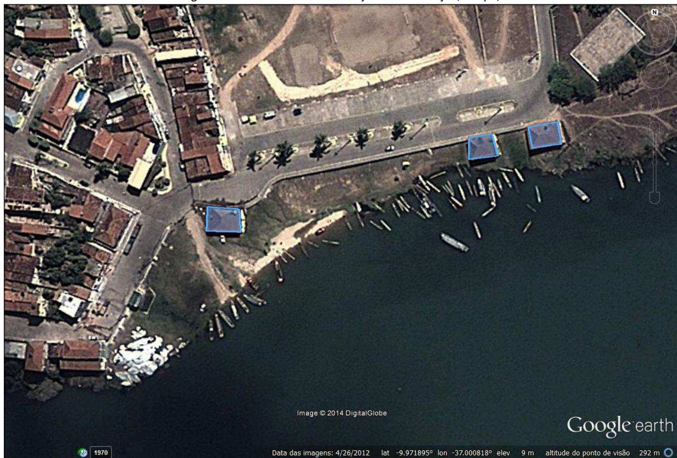
Figura 19– Bares da Orla Fluvial sujeitos a inundação, Traipu/AL.
