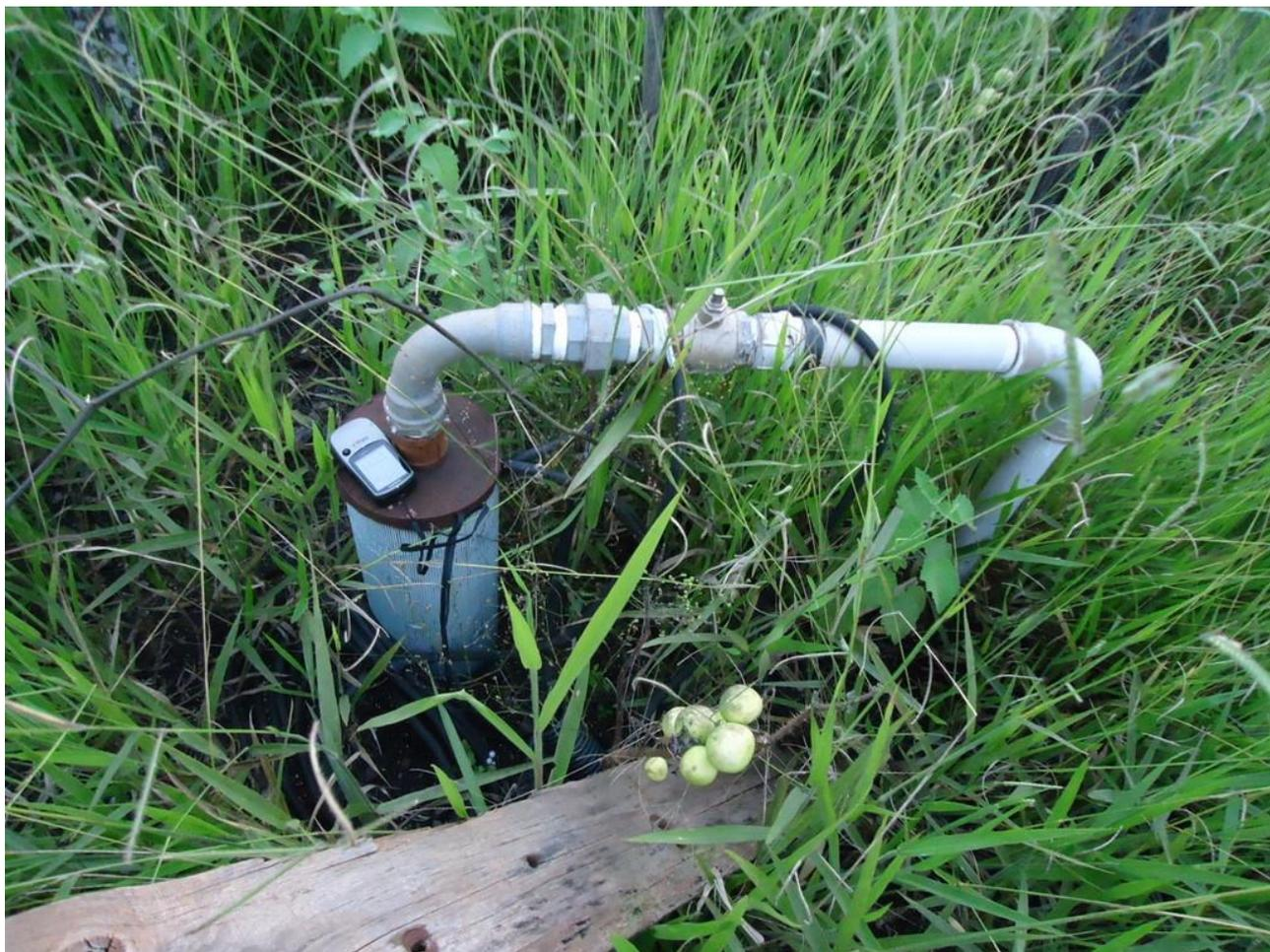
*Figura 1.24 – Exemplo de poço cadastrado no Rio Grande do Sul sem proteção sanitária (laje de proteção e cimentação do espaço anular).*
