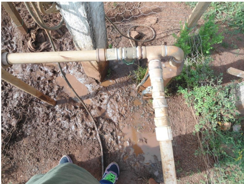
Figura 1.18 – Exemplo de poço cadastrado na área de São Gabriel do Oeste, sem proteção sanitária (laje de proteção e cimentação do espaço anular).
