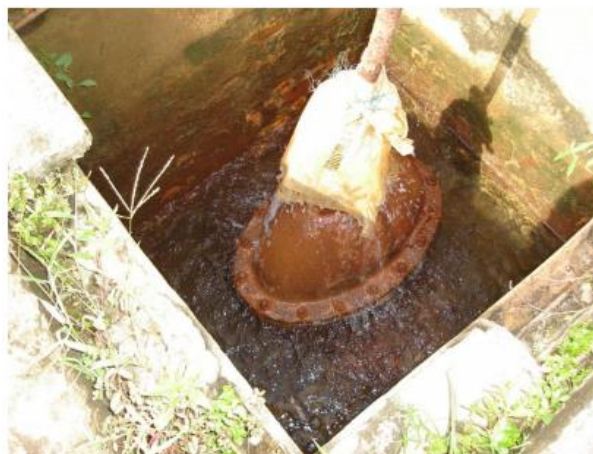
Figura 17 – (a) Vazamento em registro gaveta no 13º Setor e (b) registro rompido da adutora de água tratada do 5º Setor da COSANPA. Fonte: Veloso (2006).
