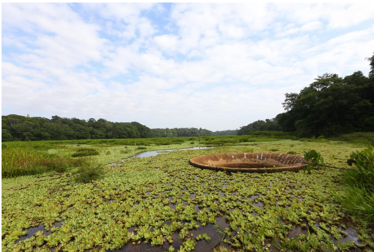
Figura 7 – Vertedor de água no lago Bolonha.
