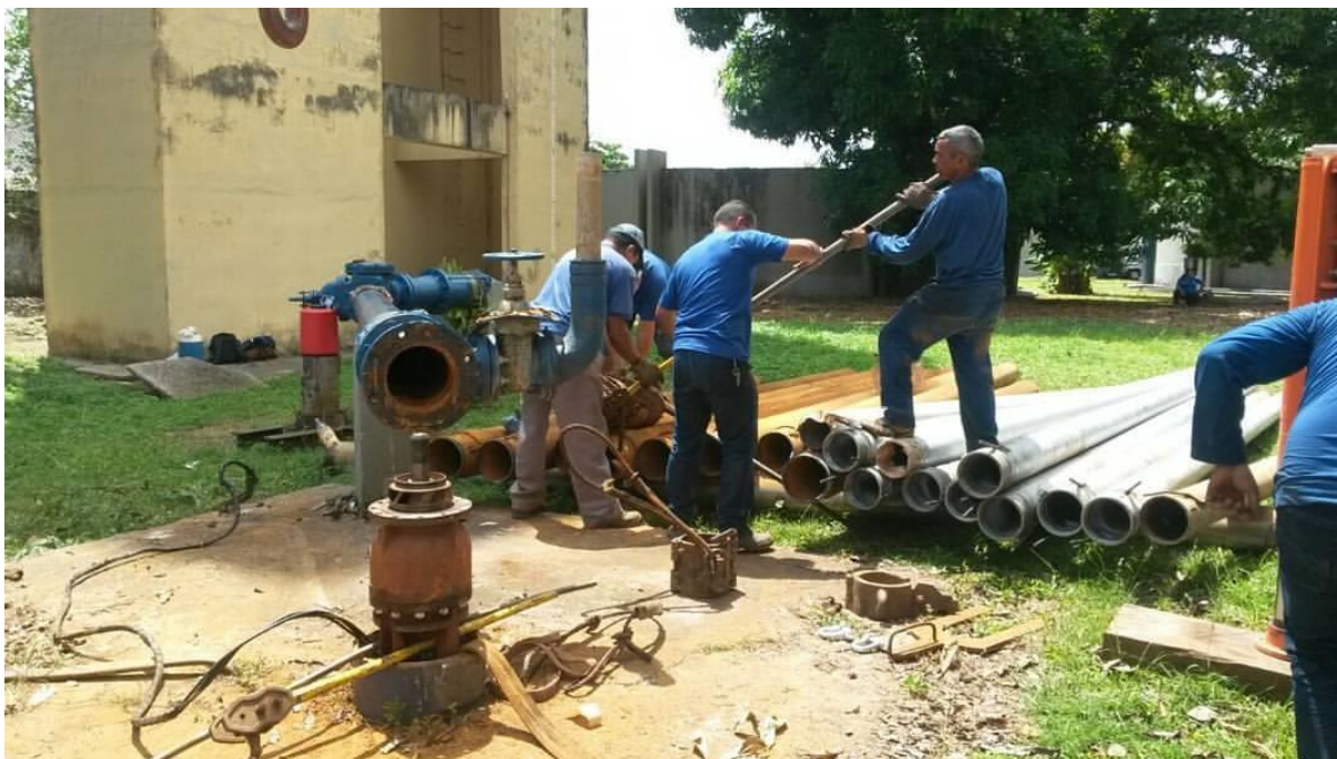
Figura 16 – Sistema Isolado Sabiá, em Ananindeua, composto por dois poços profundos. Fonte: COSANPA.
