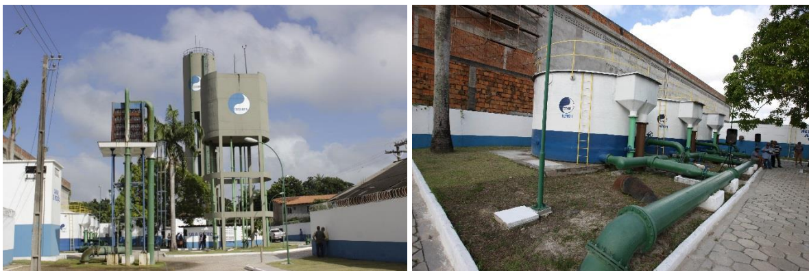
Figura 14 – Sistema Isolado Sideral, em Belém, composto por três poços profundos. Fonte: COSANPA.
