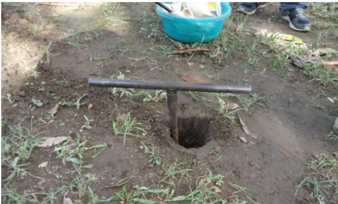
Figura 54 - Furo de 1,0 m perfurado para o teste de infiltração.
