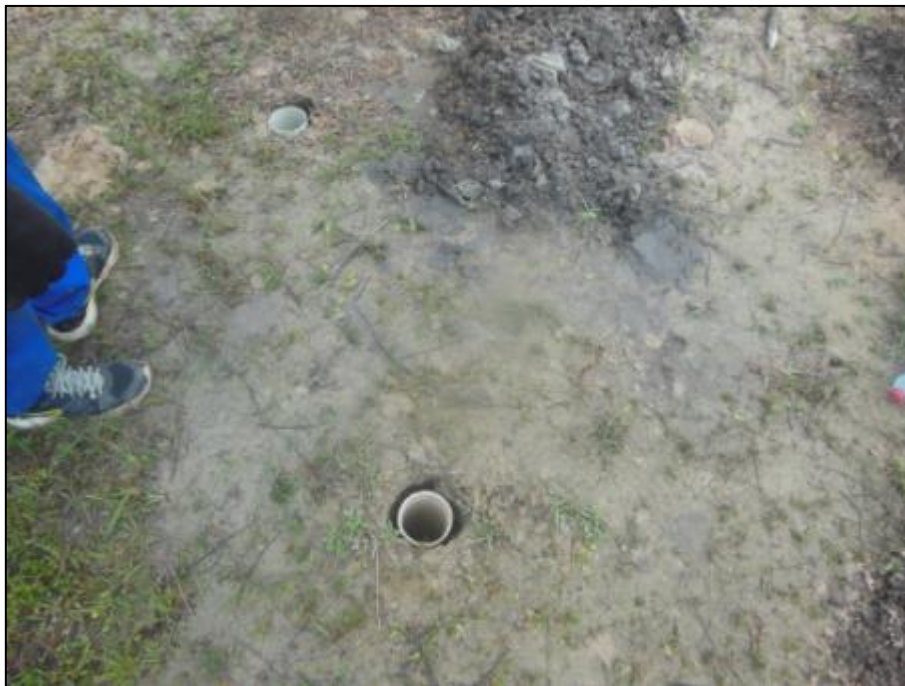
Figura 83 - Furos executados para a realização dos testes de infiltração.
