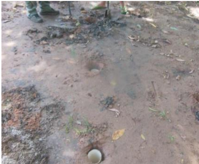
Figura 118 - Perfuração do furo de 1,5 m para o teste de infiltração.
