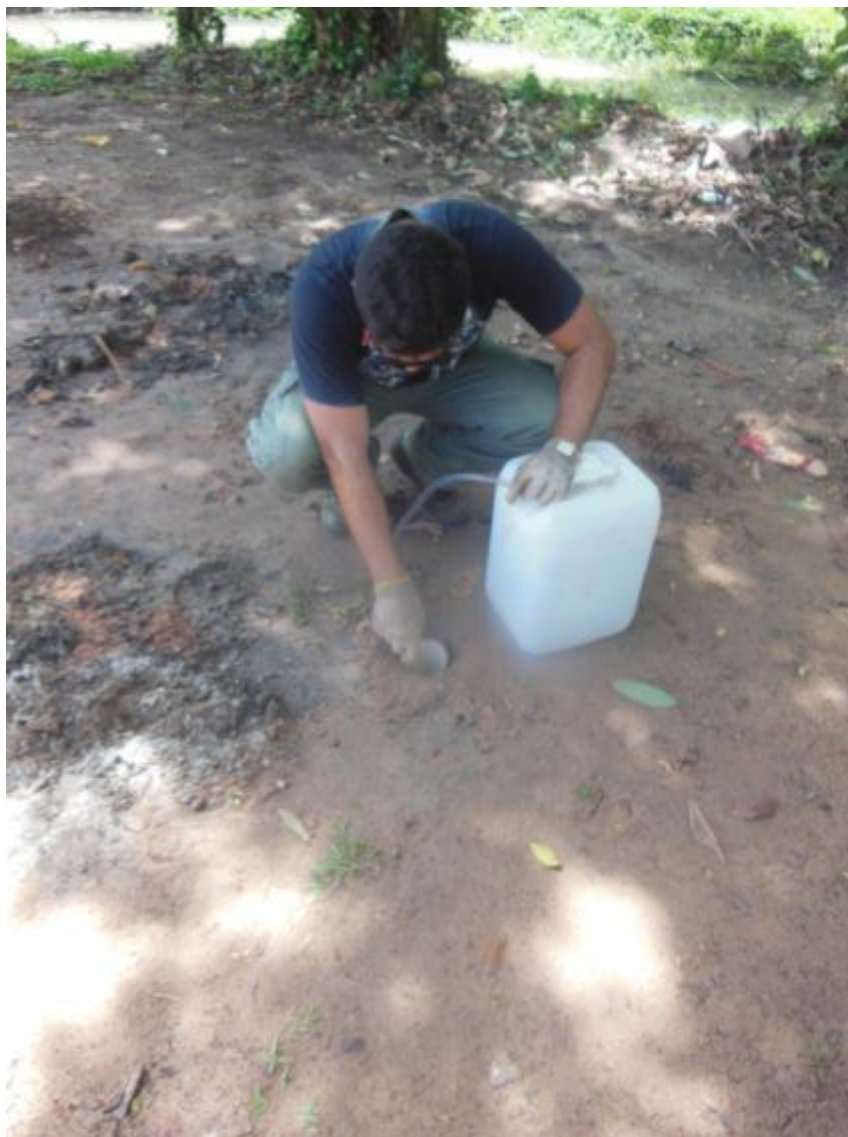
Figura 119 - Preenchimento de água no tubo para o início do teste.
