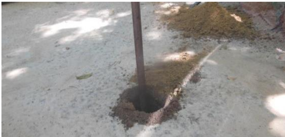
Figura 20 - Perfuração do furo de 0,5 m para a realização do teste de infiltração.
