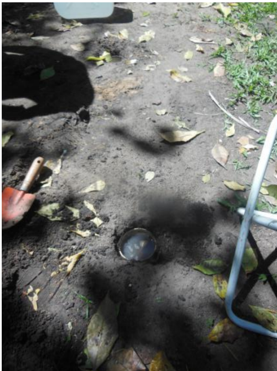
Figura 37 - Tubo cravado e preenchido com água, para o início do teste de infiltração.
