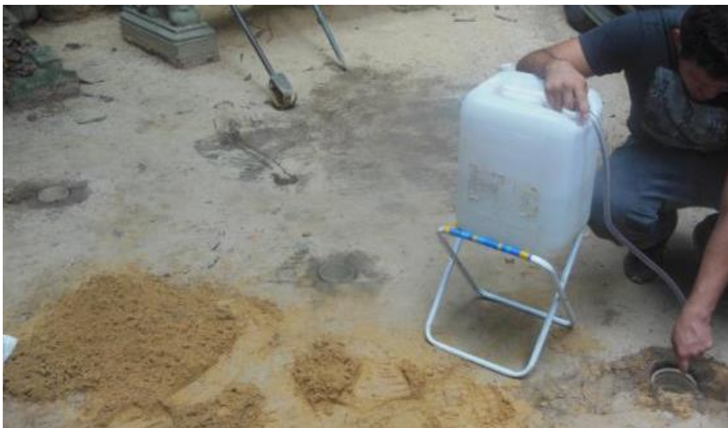
Figura 23 - Furos executados e com os tubos cravados para o início dos testes de infiltração.
