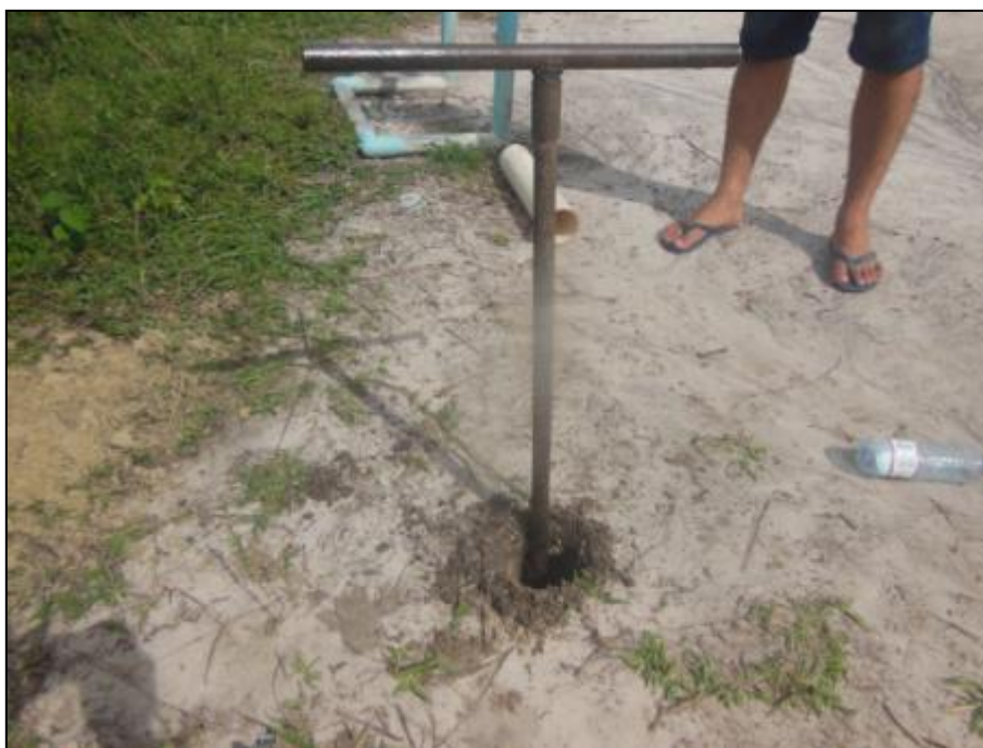
Figura 89 - Furo de 0,5 m perfurado para o teste de infiltração.
