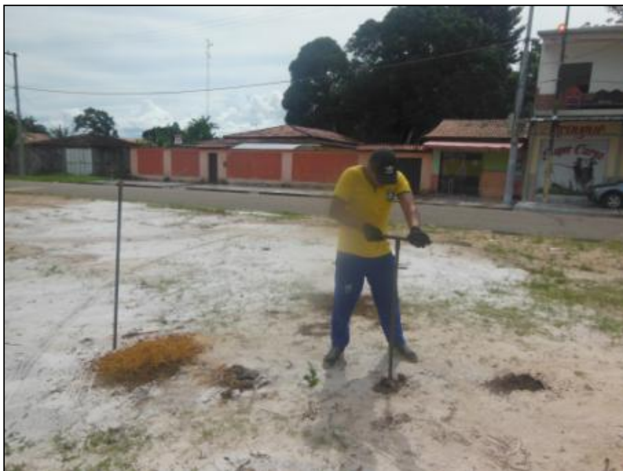
Figura 87 - Perfuração do furo de 1,5 m para a realização do teste.
