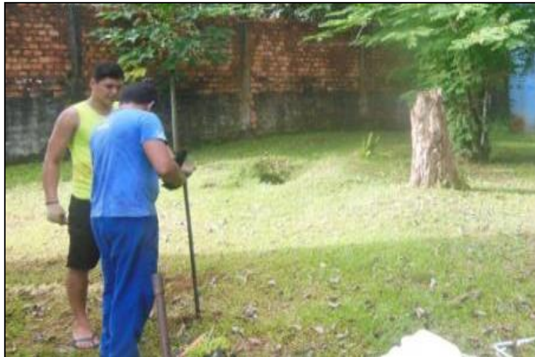
Figura 66 - Início da perfuração do furo de 0,5m.
