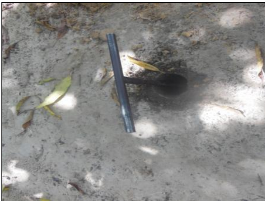
Figura 103 - Perfuração do furo de 1,0 m para o teste de infiltração.
