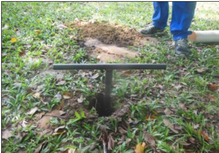
Figura 80 - Furo para a execução do teste na profundidade de 1,0 m.
