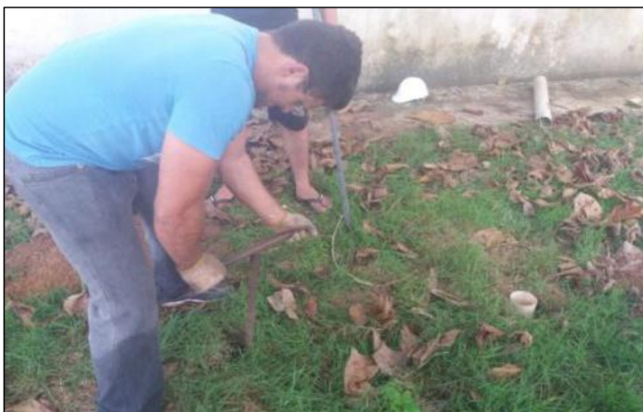
Figura 12 - Furo de 0,5m para execução do teste.
