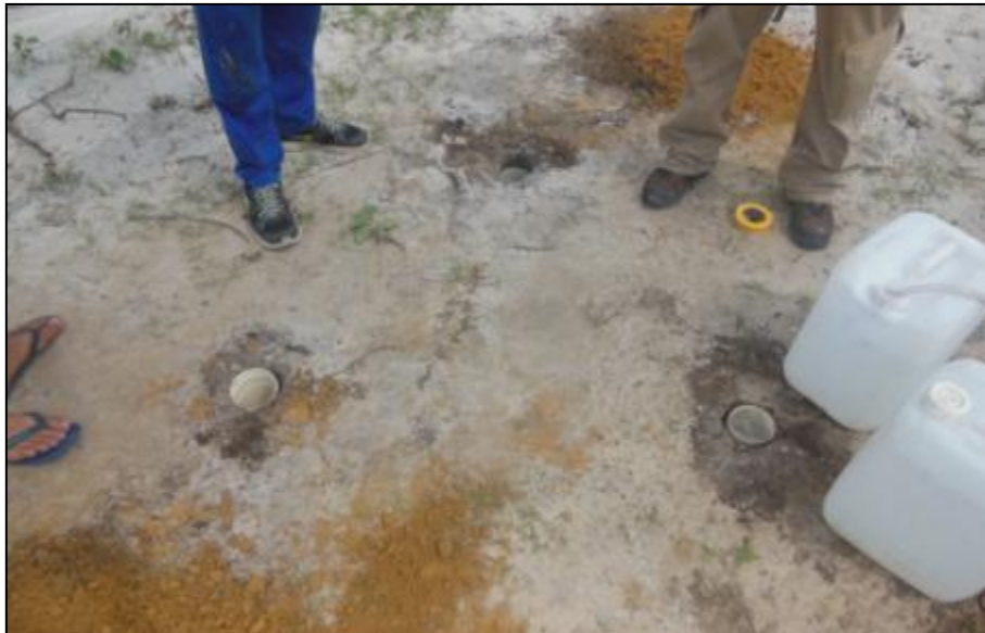
Figura 86 - Furos com tubos cravados para o início dos testes de infiltração.
