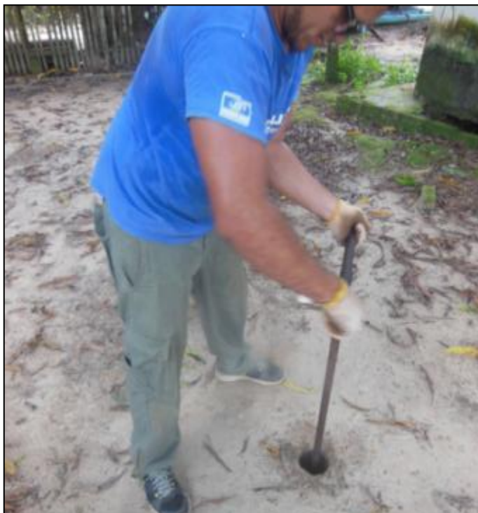
Figura 102 - Perfuração do furo de 0,5 m para o teste de infiltração.
