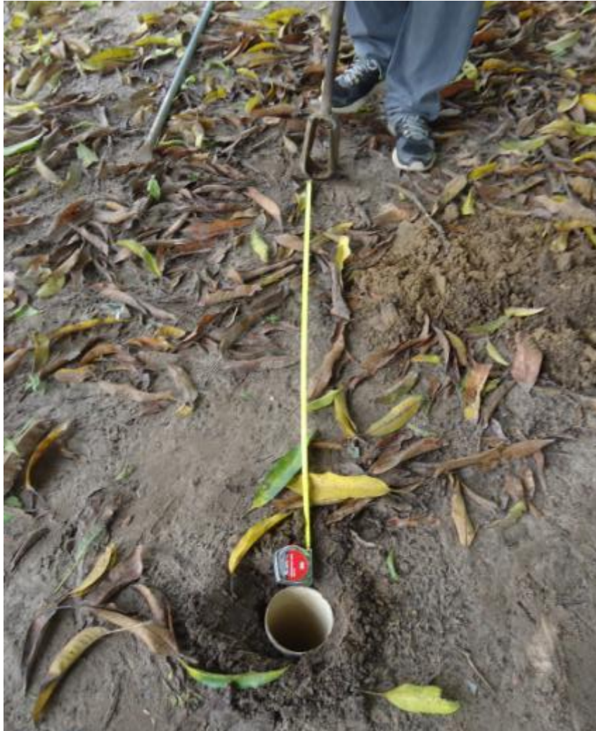
Figura 107 - Início da Perfuração do furo de 1,0 m para o teste de infiltração.
