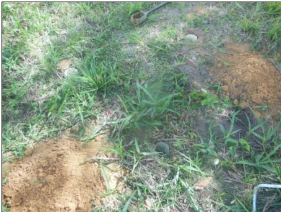
Figura 111 - Furos em diferentes profundidades 0,5 m, 1,0 m e 1,5 m para a realização dos testes de infiltração.
