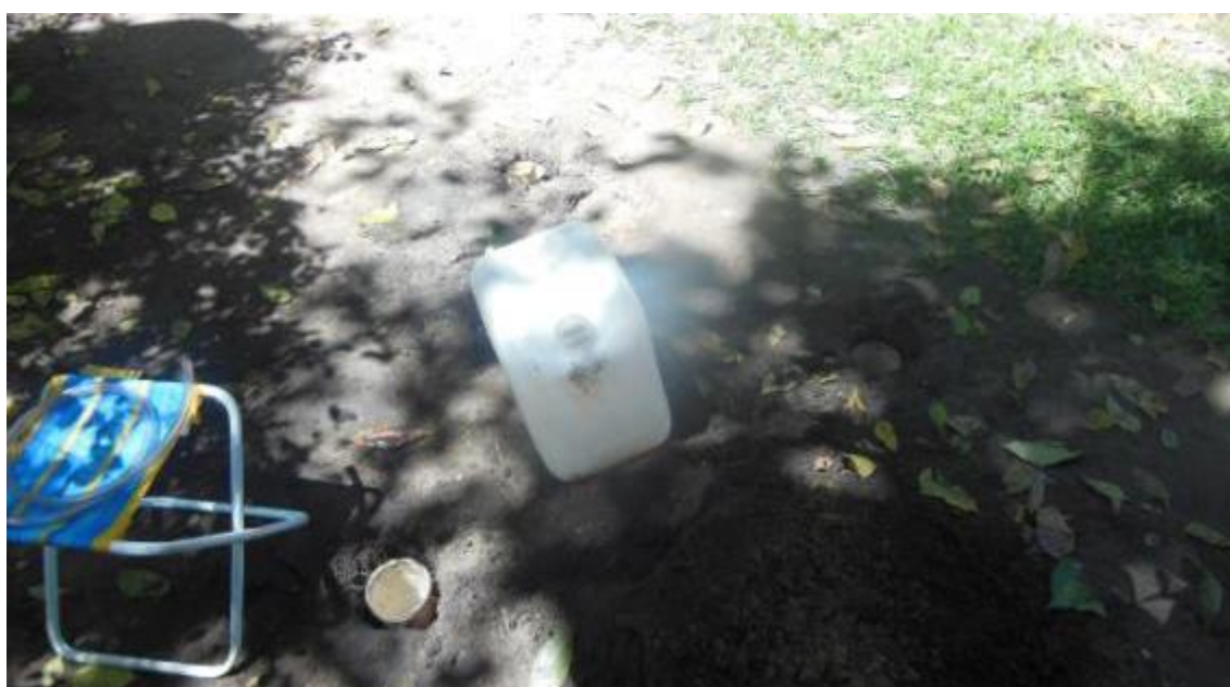
Figura 39 - Furos utilizados para o teste de infiltração.
