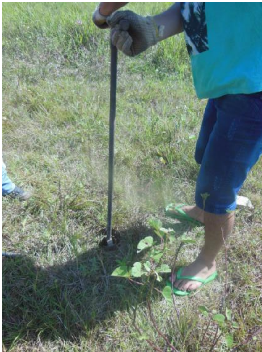
Figura 115 - Início da perfuração do furo de 0,5 m.
