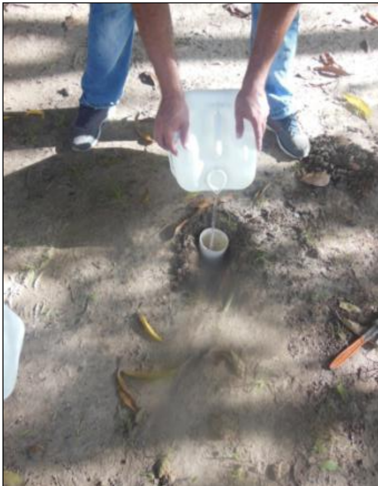
Figura 47 - Preenchimento de água no furo para o início do teste de infiltração.
