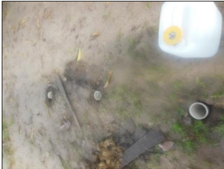
Figura 46 - Furos executados para o teste de infiltração no Ponto 14.
