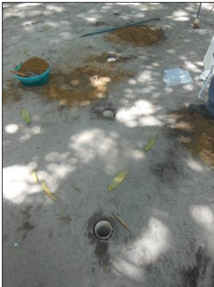
Figura 27 - Furos executados e com os tubos cravados para o início dos testes de infiltração.
