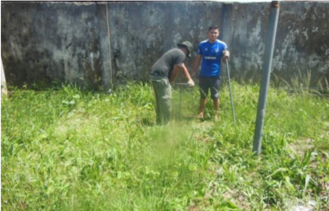
Figura 124 - Início da perfuração do furo de 0,5m.
