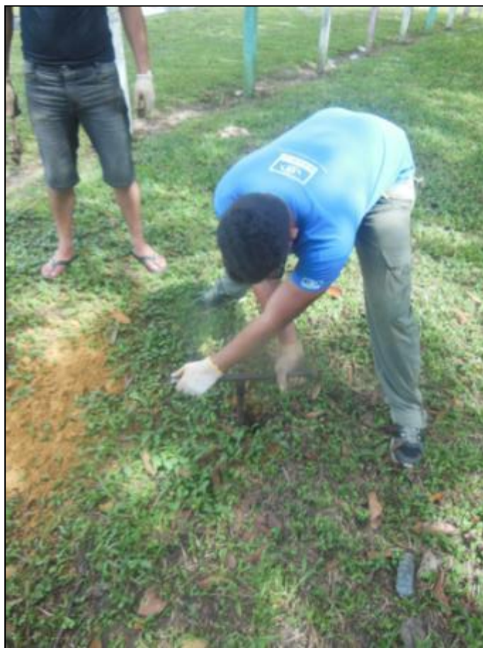
Figura 129 - Perfuração do furo de 1,0 m para a execução do teste de infiltração.
