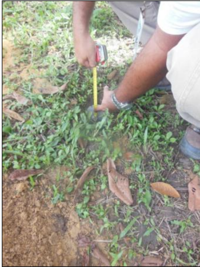
Figura 130 - Medição da variação do nível d'água no tubo cravado.
