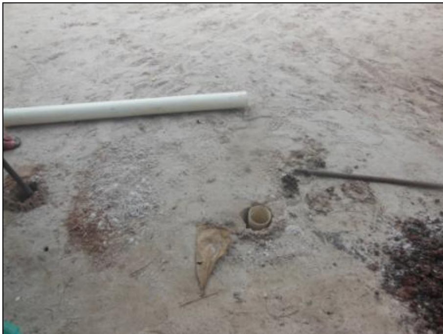
Figura 94 - Início da perfuração do furo para o teste de infiltração.
