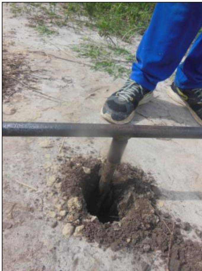
Figura 90 - Furo de 1,0 m perfurado para o teste de infiltração.
