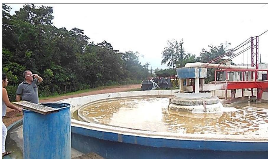
Figura 23 - Estação de Tratamento de Efluentes do Curtume Ideal. São tratados efluentes de operação de caleiro, efluentes de operação de cromo e efluentes gerais.
