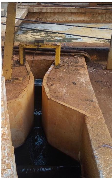
Figura 24 - Medidor de vazão, calha Parshall, do Curtume Couro do Norte.
