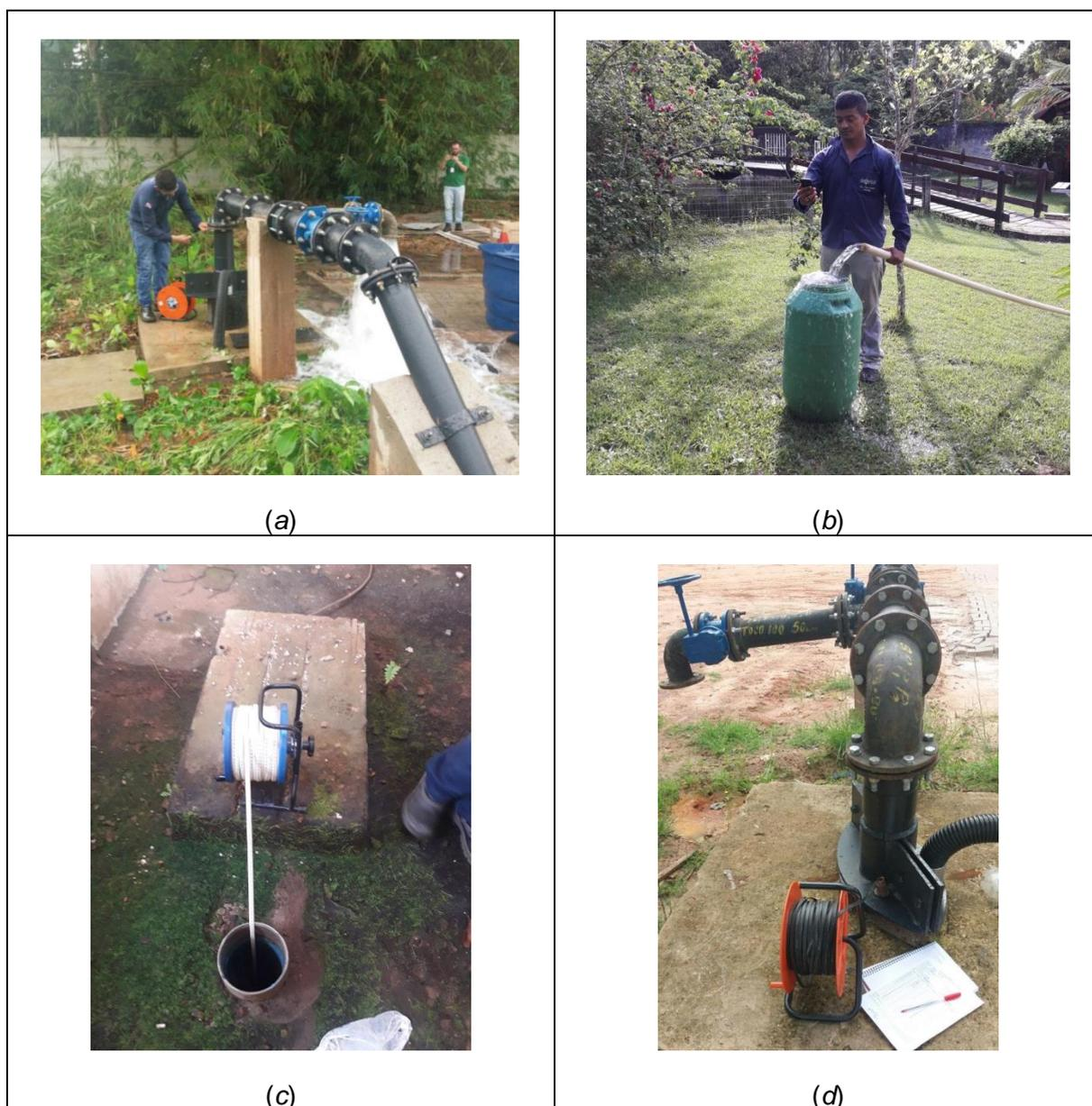
Figura 76 – Testes de aquífero. (a) poço bombeado, em Belém; (b) medição de vazão durante o teste, em Cotijuba; (c) poço de observação, em Benevides; e (d) poço de observação, em Belém (PA).
