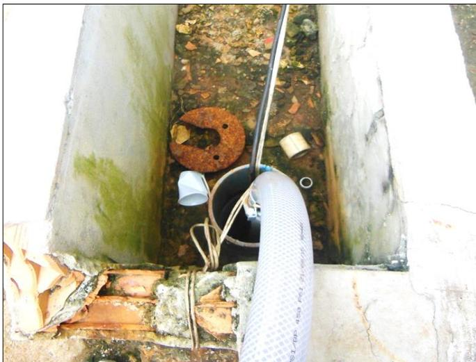
Figura 19 - Detalhe da situação do poço (Bomba P-1) do Curtume Ideal. Sem tampa de proteção.
