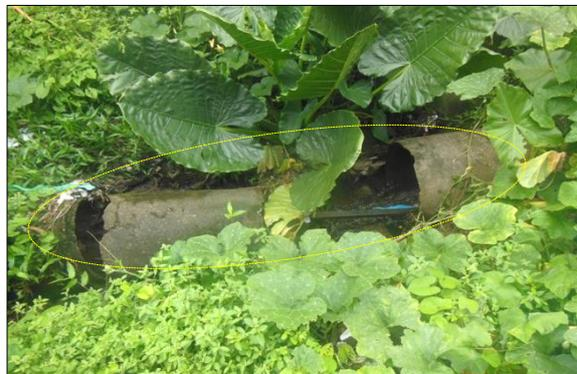
Figura 58 - Canaletas da rede de esgoto quebradas na Ilha de Mosqueiro.
