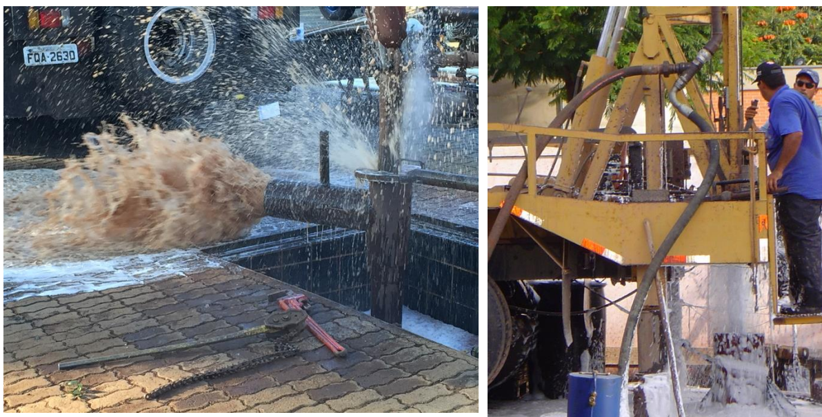
Figura 9 – Desenvolvimento com compressor.
