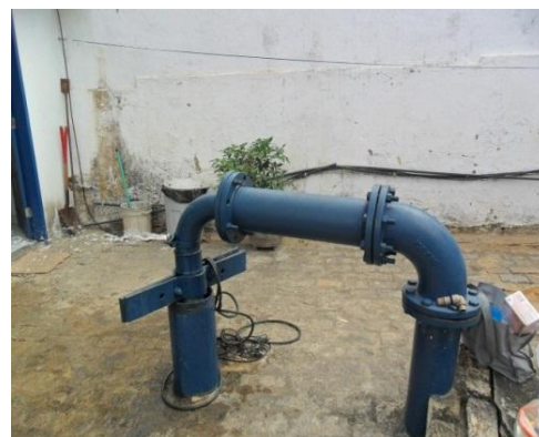
Foto 04. Poço com laje de proteção, cercado e sem tampa
