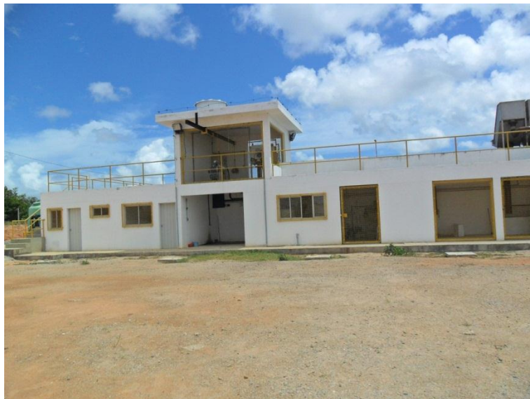
Foto 18. Vista parcial das instalações da ETE Liberdade em Parnamirim
