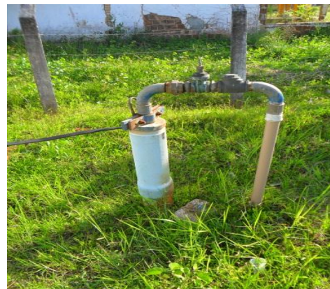
Foto 02. Poço cercado e sem laje de proteção
