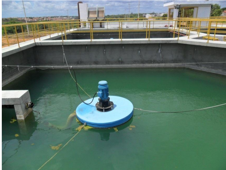
Foto 17. Vista do tanque de tratamento da ETE Liberdade
