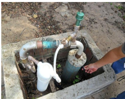
Foto 03. Poço com tampa e com laje de proteção
