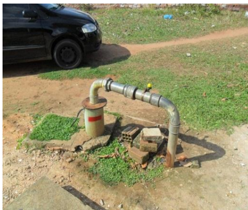
Foto 01. Poço sem laje de proteção e sem cerca
