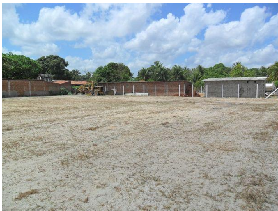
Foto 09. Vista do interior da futura lagoa Moita Verde em obras
