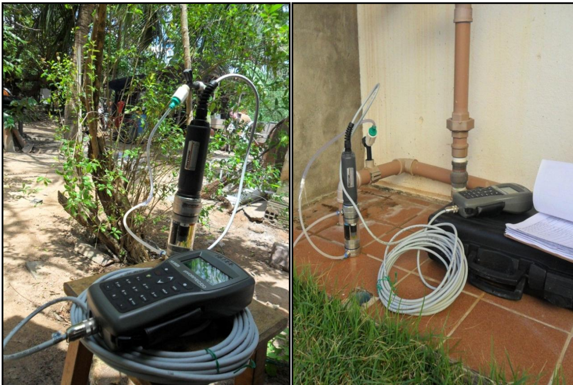
Fotos 20 e 21. Instalações de torneiras e monitoramento de parâmetros físico-químicos
