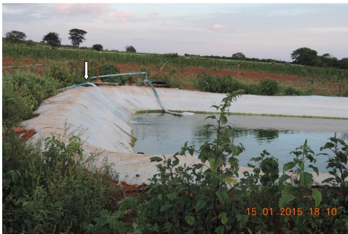
Figura 6.34: Reservatório muito próximo (em torno de 25 m), do Poço PB HUGO no qual foi lançada a descarga da água do teste para armazenamento e distribuição por meio de microaspersores em campo de lavoura a 250 m de distância, na Fazenda Morro Pelado I.
