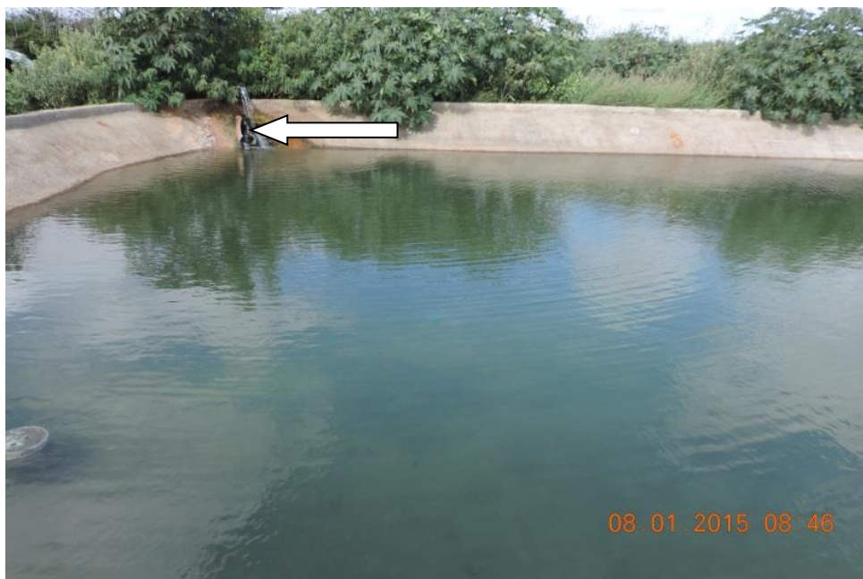
Figura 6.9: Reservatório para onde foi canalizada a água bombeada do poço PB Marcos, situado a 38 m de distância. A seta aponta o local de descarga da d'água. Embora seja uma potencial fonte de retorno da água para o condutor hidráulico, não há evidência de que isto tenha ocorrido de forma significativa.
