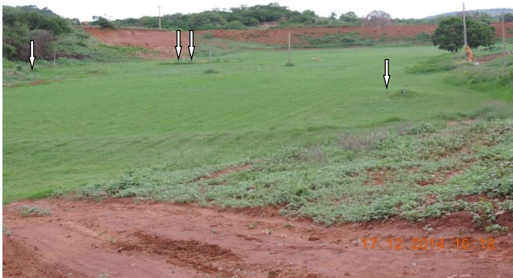
Figura 6.27: Vista geral do vale onde se localizam os 4 (quatro) poços envolvidos no teste de aquífero. Da esquerda para direita, mostra-se o Poço Bombeado PB, Poço Observado 1; Poço Observado 2 e Poço Observado 3. Ao fundo, a barragem a montante dos poços.
