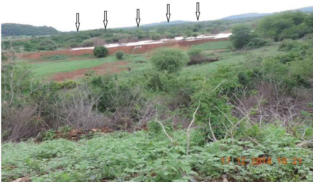
Figura 6.28: Barragem construída no início do ano de 2014 já com bastante água acumulada no momento do teste. Ainda não “sangrou”. Esta barragem fica 139 m a montante dos poços mostrados na Figura 6.29.
