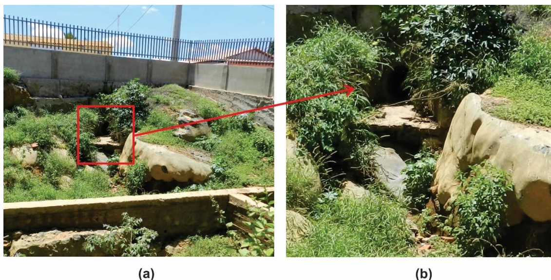
Figura 9.4: Sumidouro localizado na Rua José Vitor Carvalho. (a) Vista da área construída ao redor do sumidouro; (b) Manilha onde a água pluvial é escoada dos arredores até o local.
