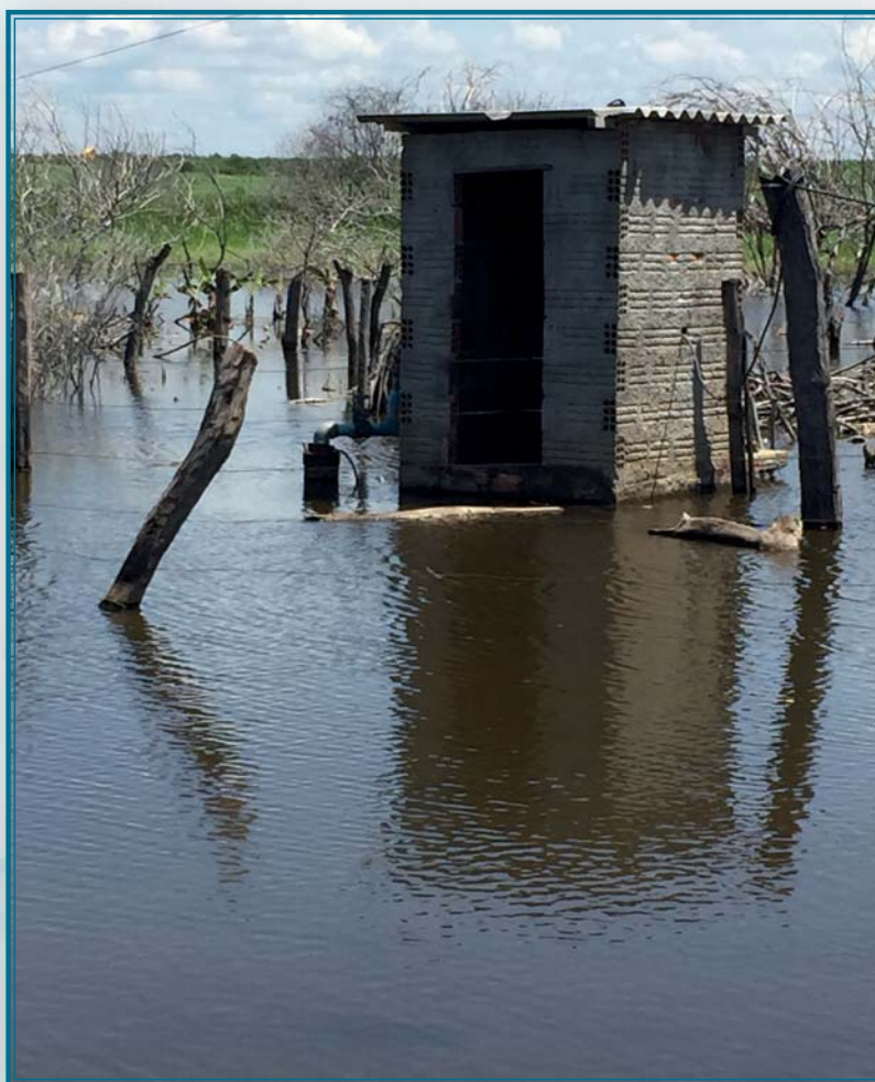
Poço tubular submerso em área de surgência, Jaíba (MG)
