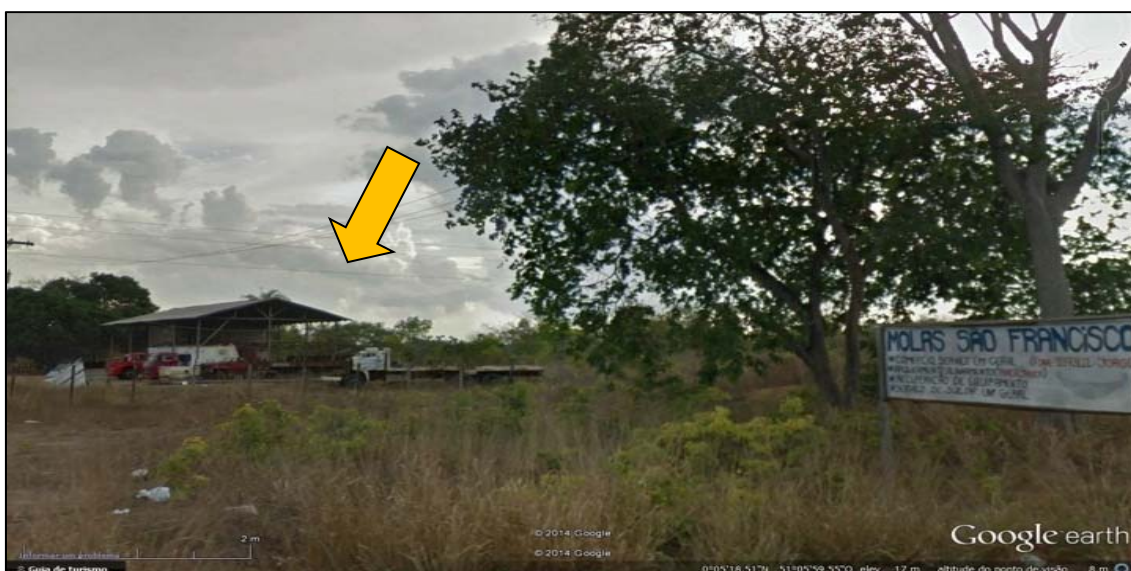
Foto 6.3 – Galpão de oficina mecânica, onde está localizado o poço MPA28.
