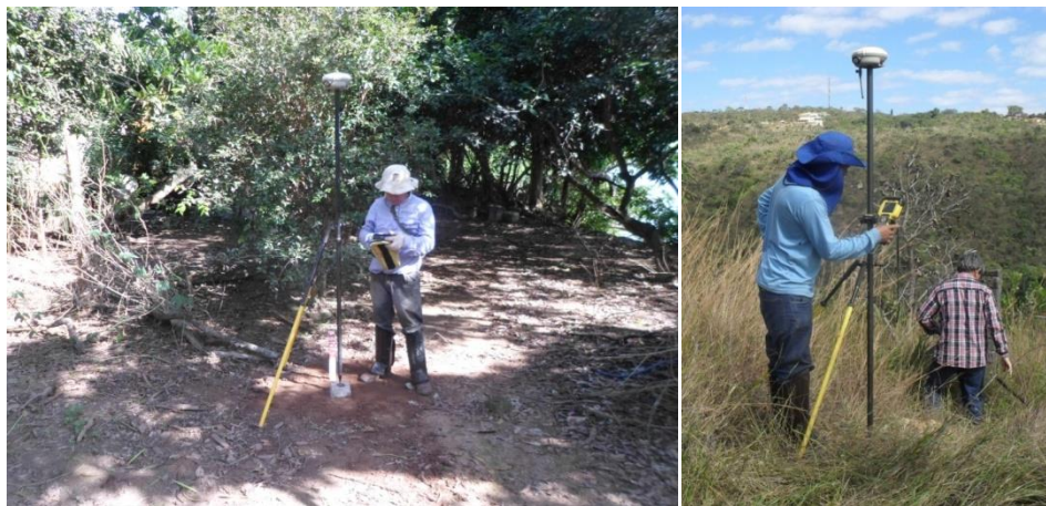
Figura 77 - Levantamento de Seções Topobatimétricas com receptor RTK.
