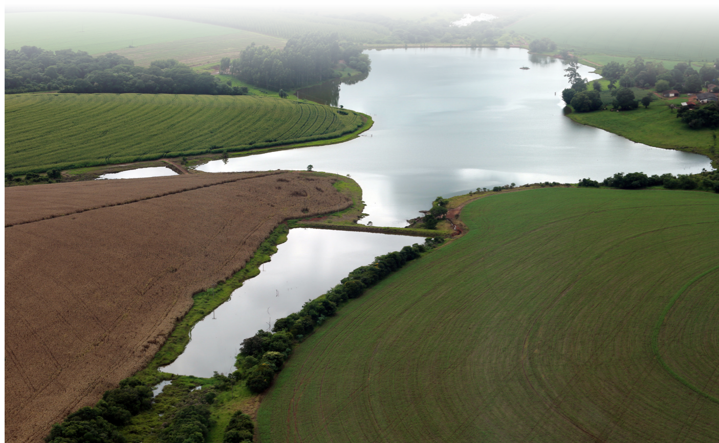
Barragens para irrigação em Taquarivaí (SP) Raylton Alves / Banco de imagens ANA
